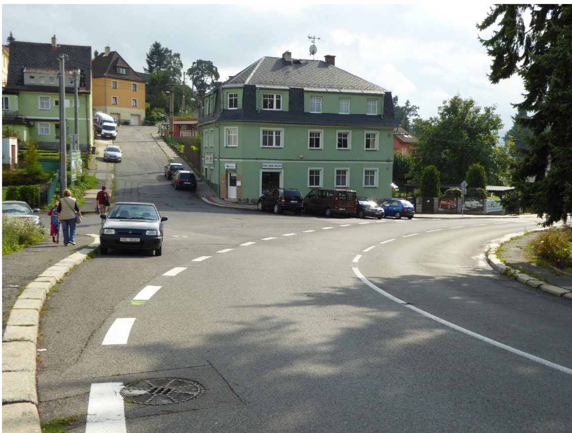
Obr. 3: Ul. Ruprechtická – nevyřešené nároží s ul. U Pramenů
