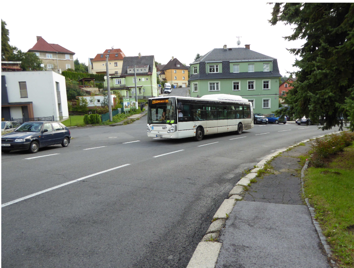
Obr. 2: Ul. Ruprechtická – nevyhovující stav povrchu chodníku pro chodce, vyvrácené obruby
