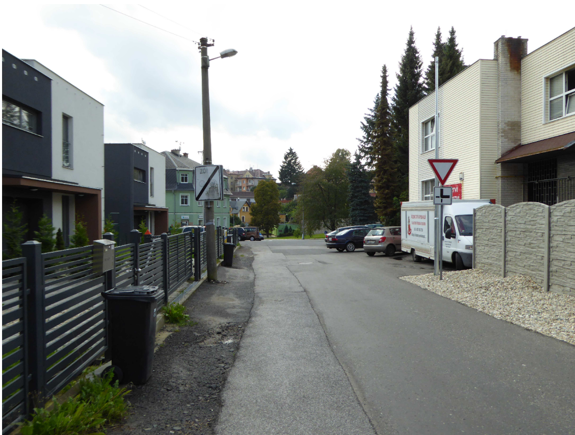
Obr. 12: Ul. U Pramenů – provizorně provedený povrch vozovky samostatných sjezdů
