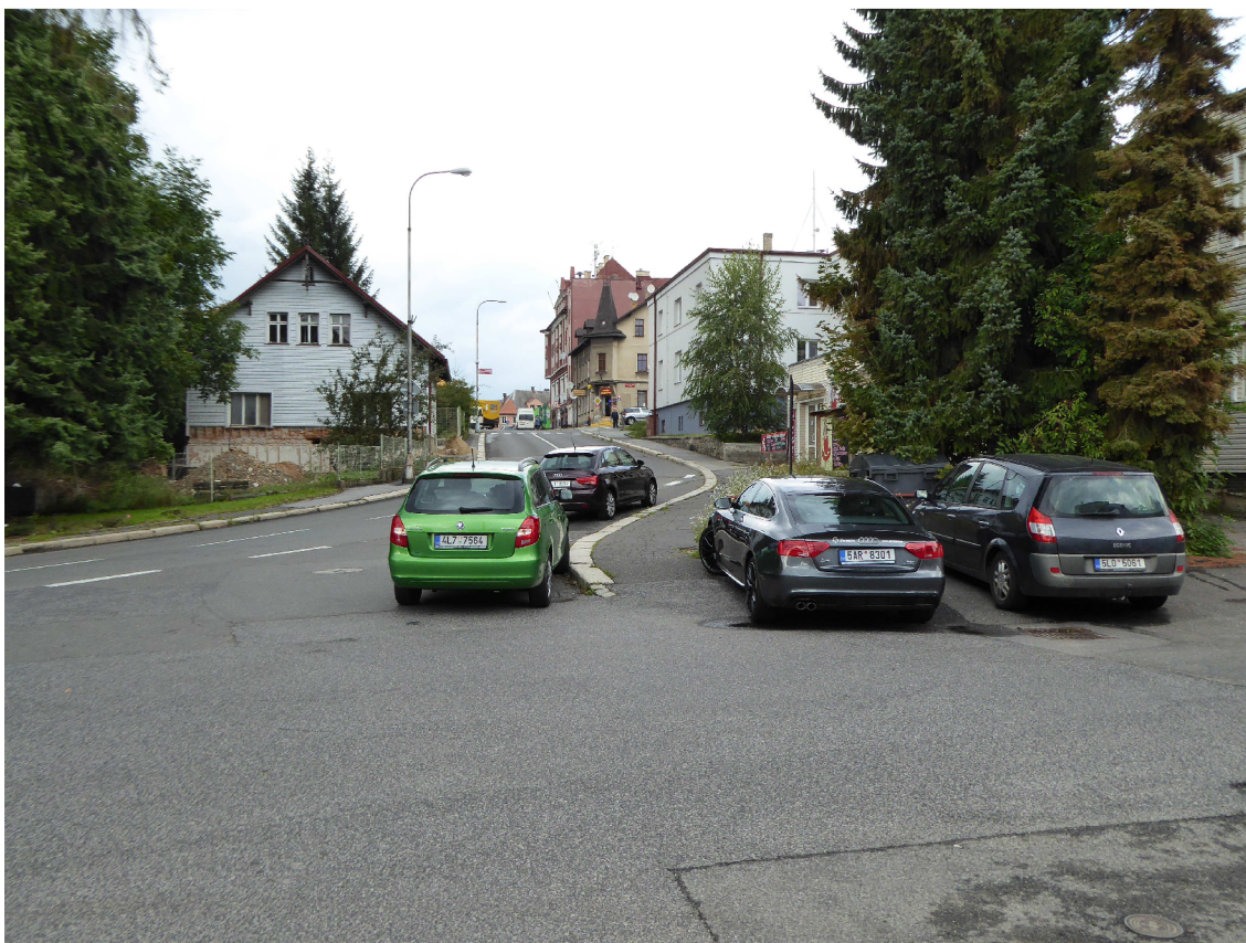
Obr. 11: Ul. U Pramenů – parkování vozidel v nároží křižovatky s ul. Ruprechtickou, nevyhovující úprava chodníku pro chodce, resp. chybějící místo pro přecházení
