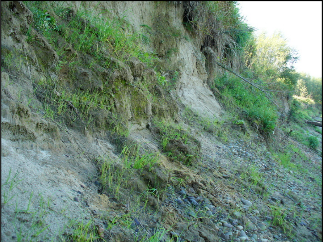
Obnažený břeh řeky Bečvy (Osek nad Bečvou)
