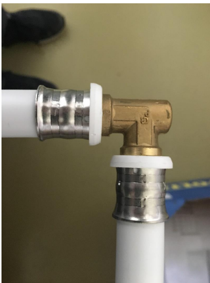
Obrázek 89 - Tvar fitinky po zalisování
