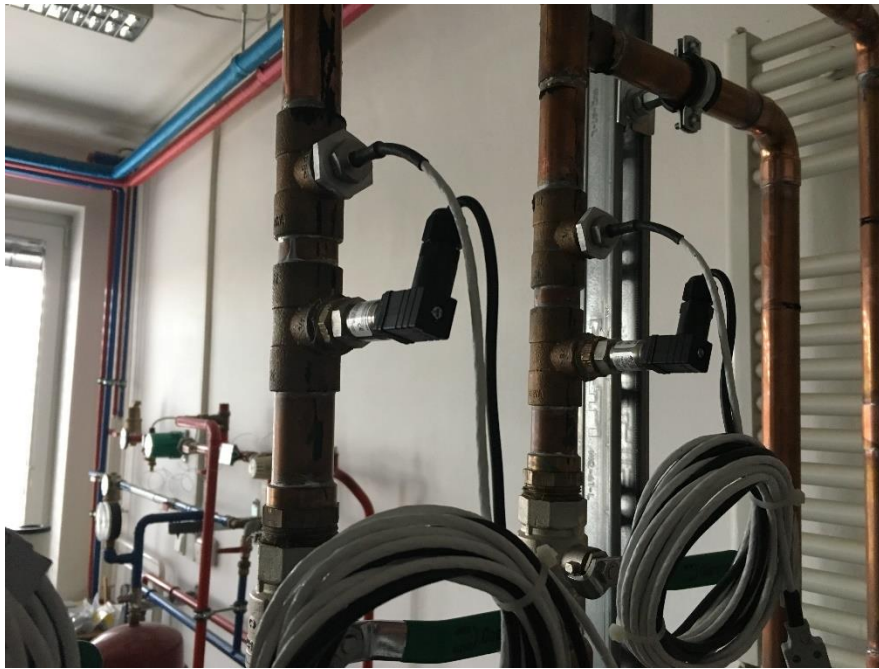
Obrázek 95 - Vyvažovací ventil pro změnu průtoku
