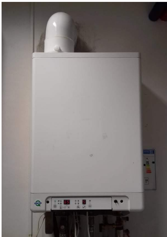
Obrázek 96 - Plynový kotel pro ohřev otopné vody na požadovanou teplotu
