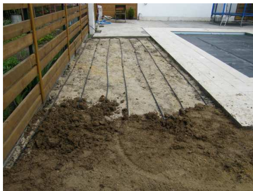
Obr. č. 3: Příklad pokládky kapkové závlahy podzemní [26]
