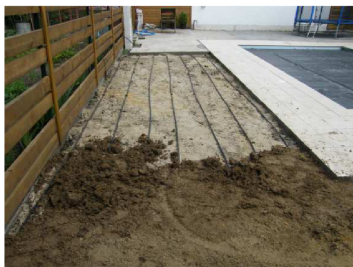
Obr. č. 3: Příklad pokládky kapkové závlahy podzemní [26]
