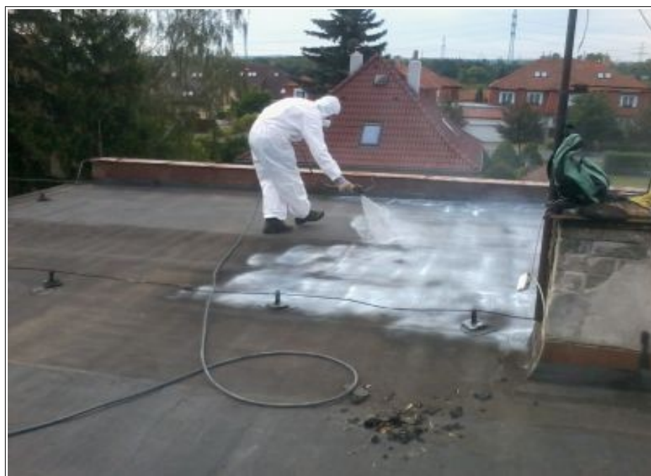
Obr. 24: Penetrace asfaltových pásů enkapsulantem (zdroj: EKOSTAR, ©2017b)
