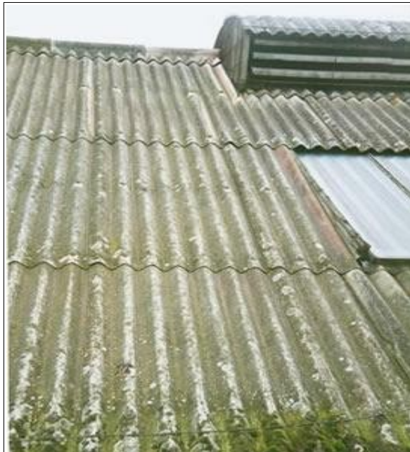
Obr. 8: Eternitová střešní krytina (zdroj: OMNIPURE, ©2016c)
