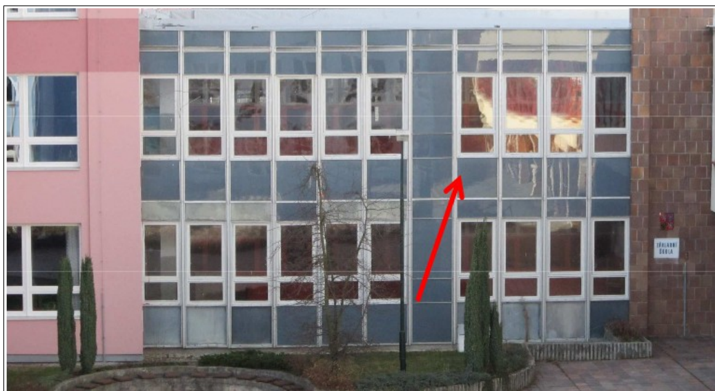
Obr. 36: Pavilon 423 s obvodovým pláštěm z Boletických panelů (zdroj: Foster Bohemia , ©2012)
