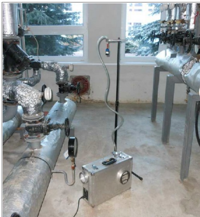
Obr. 43: Monitoring po sanaci (zdroj: Foster Bohemia , ©2012)
