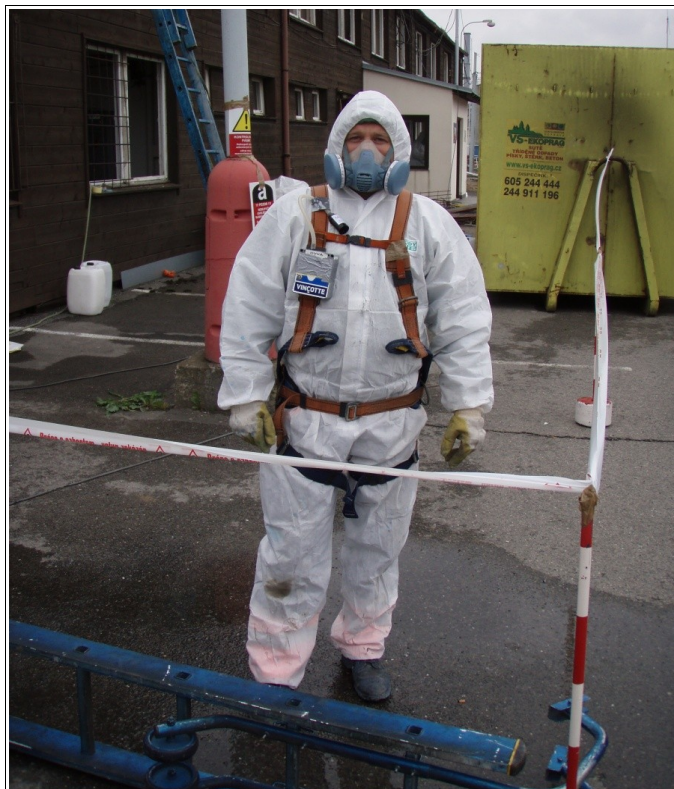
Obr. 30: Ochranná výstroj pro odstraňování azbestu (zdroj: OMNIPURE, ©2016c)
