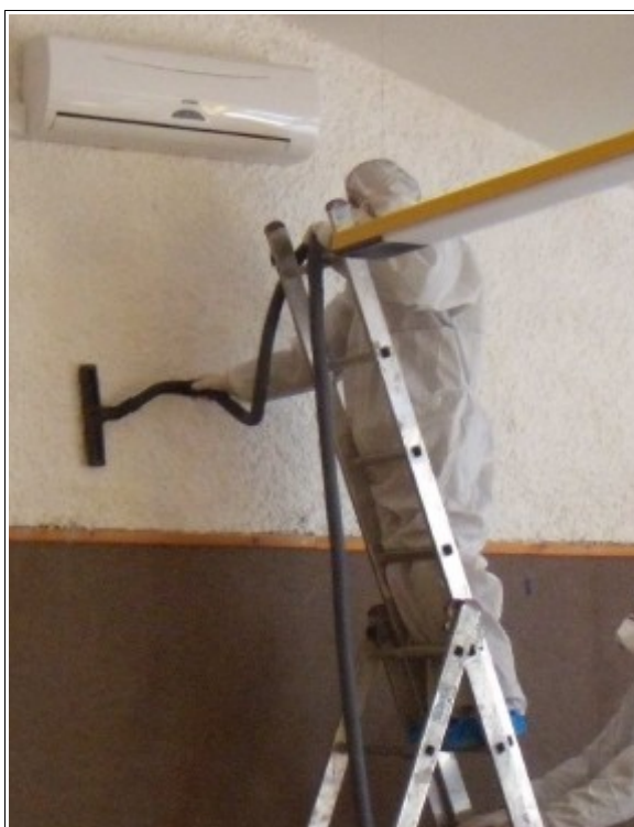
Obr. 41: Osávání prachu ze stěny (zdroj: Foster Bohemia, ©2012)
