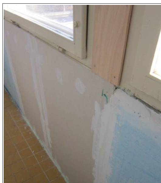
Obr. 33: Překrývání panelu sádrokartonem ( zdroj: Foster Bohemia, ©2012 )
