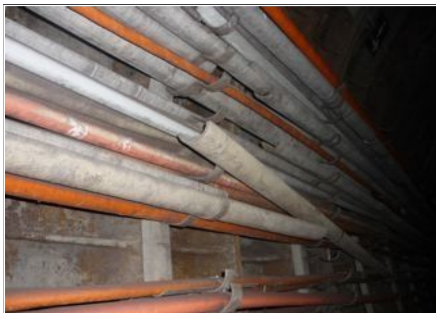
Obr. 11: Azbestocementové izolační žlaby kabeláže v pražském metru ( zdroj: Eliášová, 2009 )
