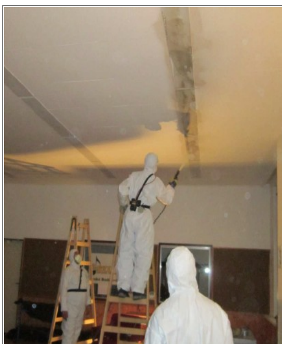
Obr. 34: Penetrace azbestových desek (zdroj: Foster Bohemia , ©2012)
