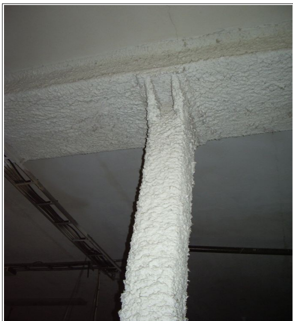
Obr. 7: Nástřík ocelové konstrukce Pyrotherm (zdroj: OMNIPURE, ©2016b)
