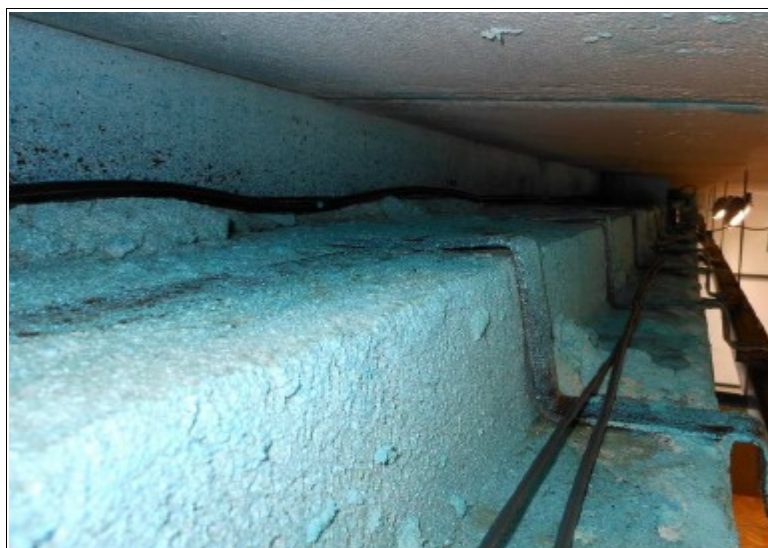
Obr. 31: Nosník napenetrovaný barevným enkapsulantem ( zdroj: Foster Bohemia, ©2012 )
