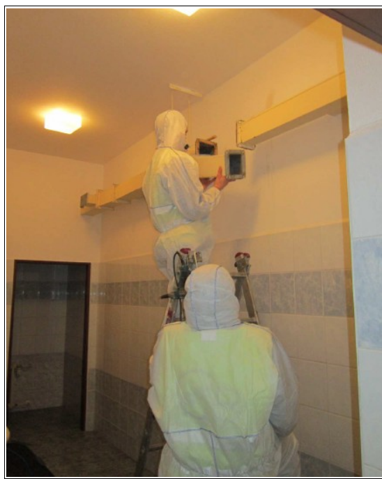
Obr. 35: Demontáž VZT potrubí (zdroj: Foster Bohemia , ©2012)
