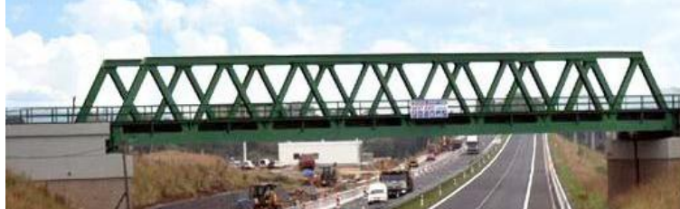
Obr. 1: železniční příhradový most nedaleko Chebu-převzato z [2]
