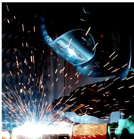
Ukázka poloautomatického svařování elektrickým obloukem tavící se elektrodou [8]
