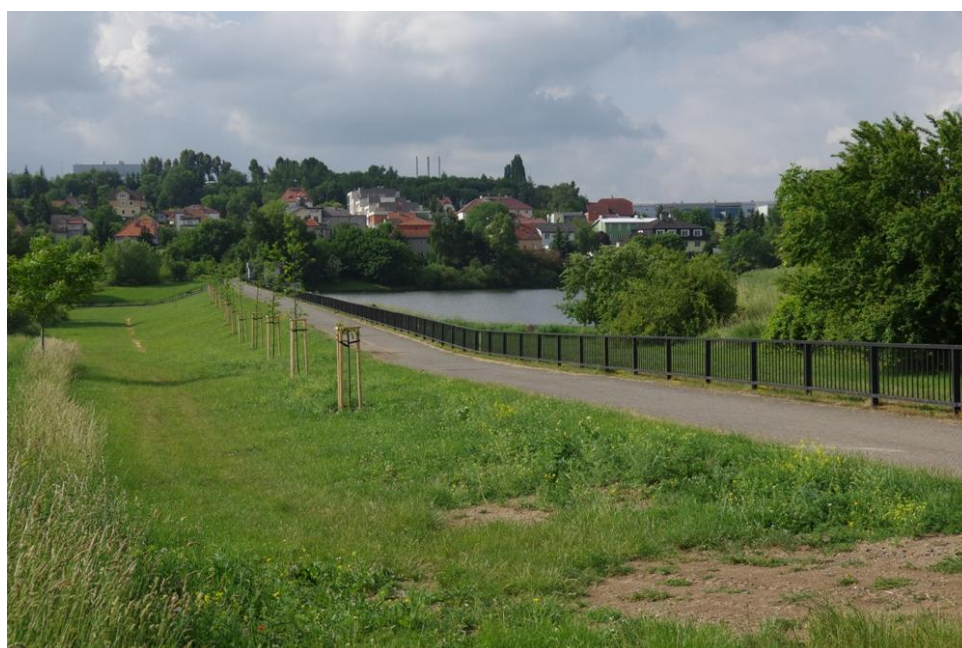
Obr. č. 11: Hráz nádrže (URL 2)
