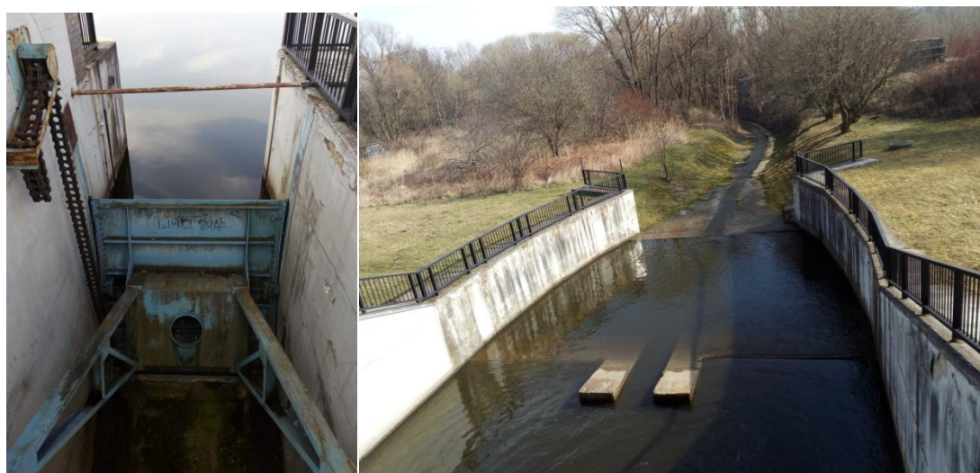
Obr. č. 8 a 9: Hrazený bezpečnostní přeliv a skluz s vývařištěm (Autor, 2017)
