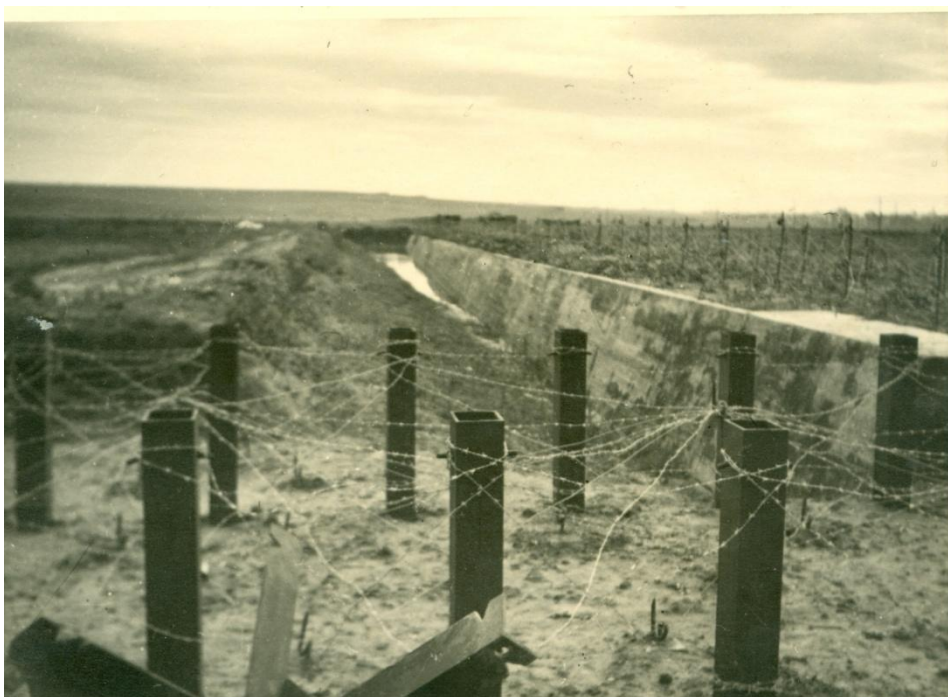
obr. 16. V pozadí fotografie pravostranný protitankový příkop severně Opavy u objektu OPS 19 s betonovou čelní stěnou a v popředí těžká překážka ze železných sloupů propletená ostnatým drátem. (archiv Mackovčín, 2017)
