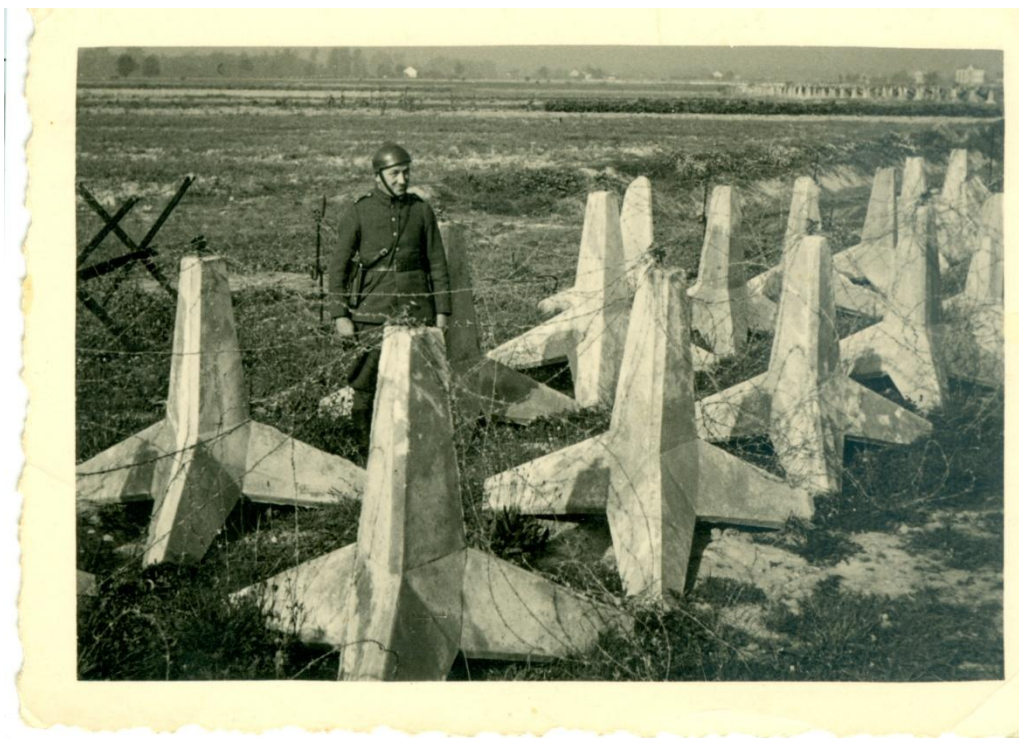
obr. 18. Polský voják pózuje u železobetonových rozsocháčů ostravského opevnění MO 3. (archiv Trkovský, 2017)
