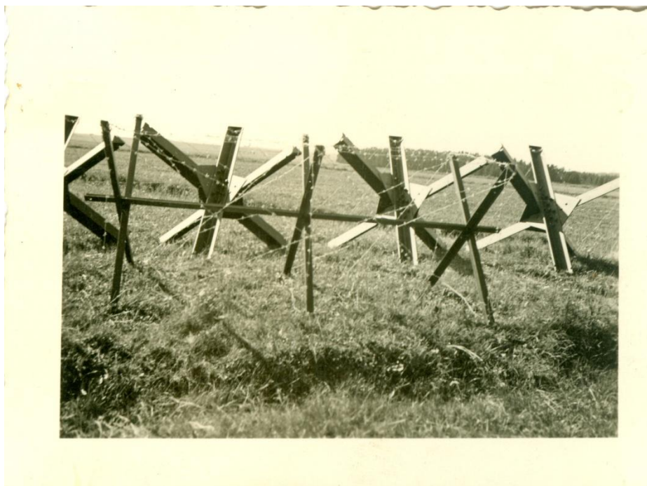
obr. 19. V pozadí fotografie příklad staršího typu železných rozsocháčů doplněna o linii “španělských jezdců” v okolí Rancířova. (archiv Mackovčín, 2017)
