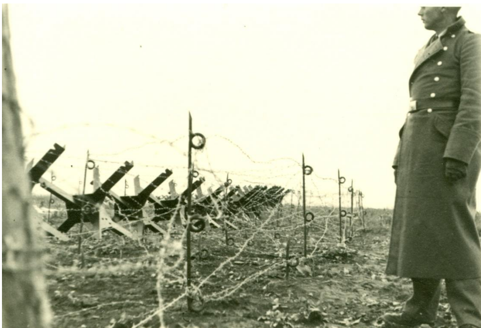
obr. 11. Příklad tříokých a jednookých kolíků s ostnatým drátem v linii pěchotního opevnění. (archiv Mackovčín, 2017)
