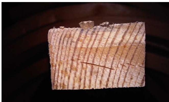
Obr. 20 Výšňové trhliny s výrony pryskyřice
