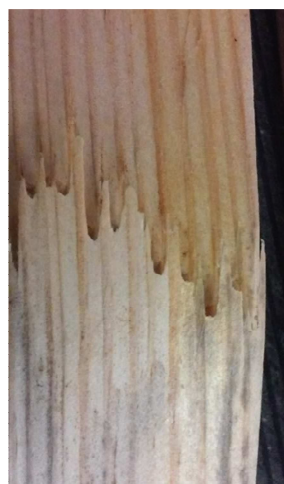
Obr. 21 Prasklina na vnější straně ohybu
