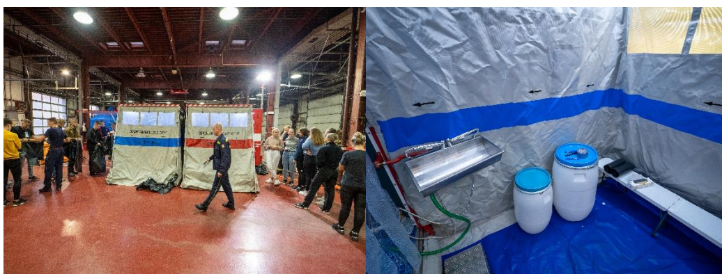
Obrázek č.16: Vstupní část dekontaminačního stanoviště.
