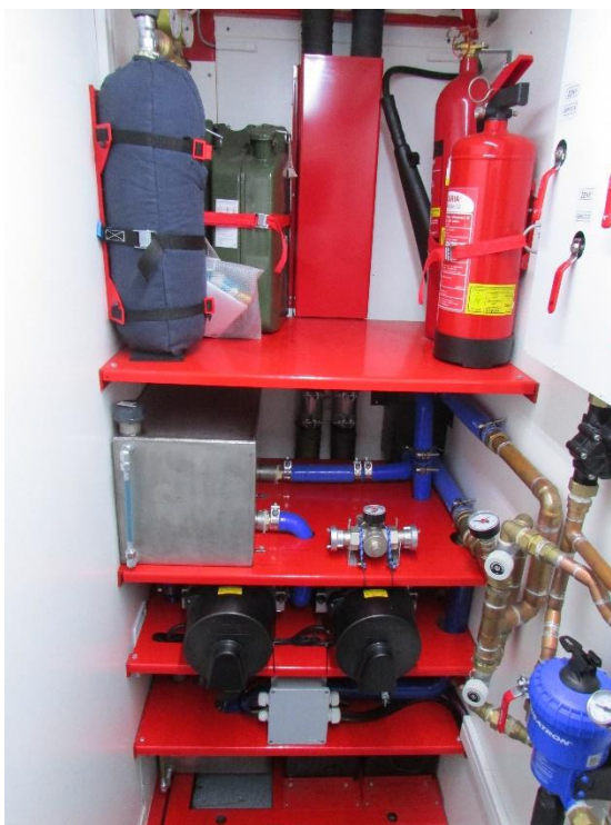
Obrázek č.10: Systém ohřevu teplé vody SDO-4.
