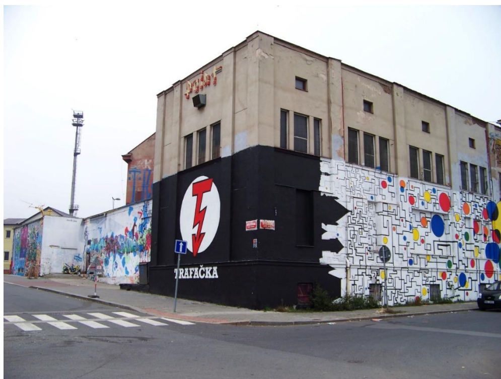
Obr. 19 pohled na budovu Trafačky
