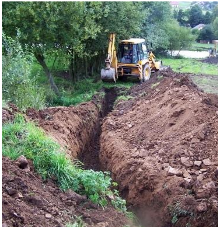
Obr. 20 Klasické hloubení výkopu bagrem [12]
