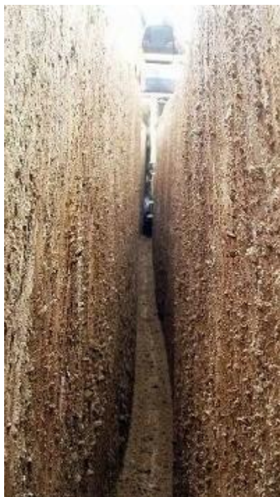
Obr. 22 Pohled do drážky od zemního rýhovače [12]
