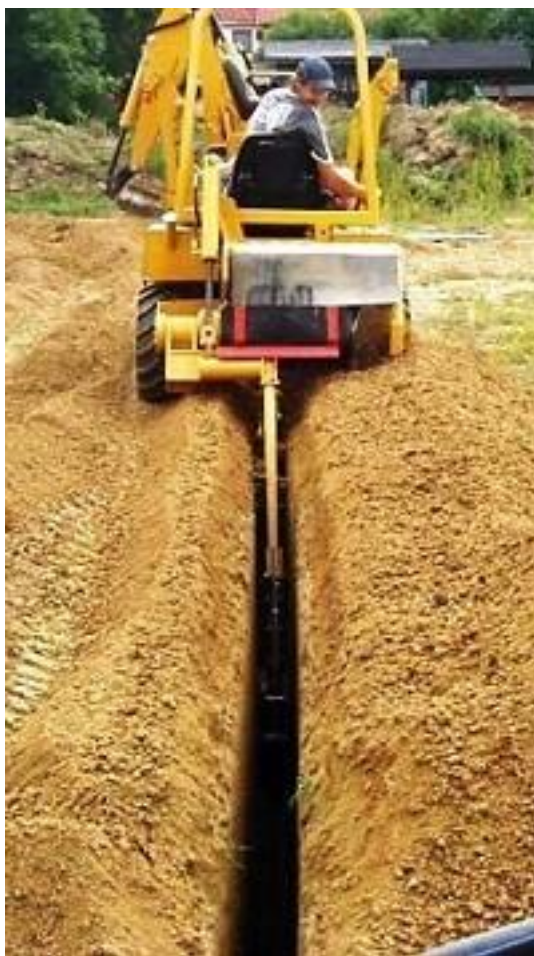
Obr. 21 Hloubení výkopu zemním rýhovačem [12]
