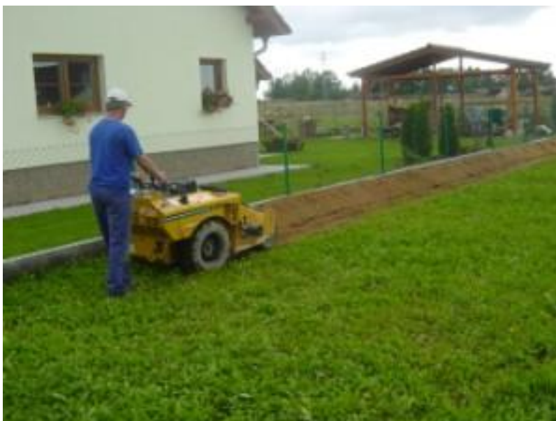
Obr. 23 Provádění zemního kolektoru pomocí drážkovačky [13]
