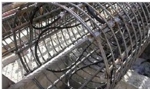
Obr. 36 Energetická pilota s vystrojením [21]
