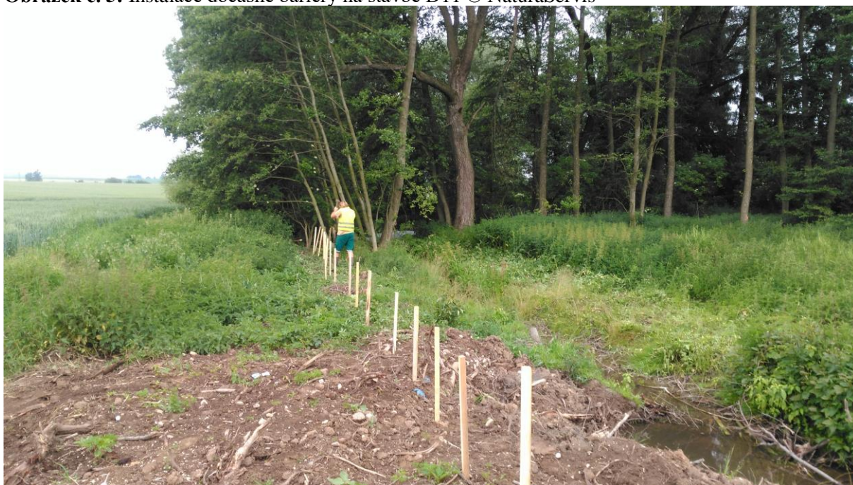
Obrázek č. 5: Instalace dočasné bariéry na stavbě D11 © NaturaServis
