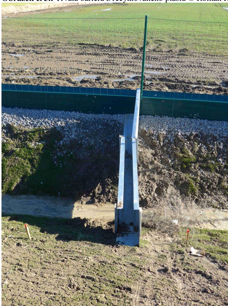
Obrázek č. 3.: Trvalá bariéra z recyklovaného plastu © Roman Rozínek
