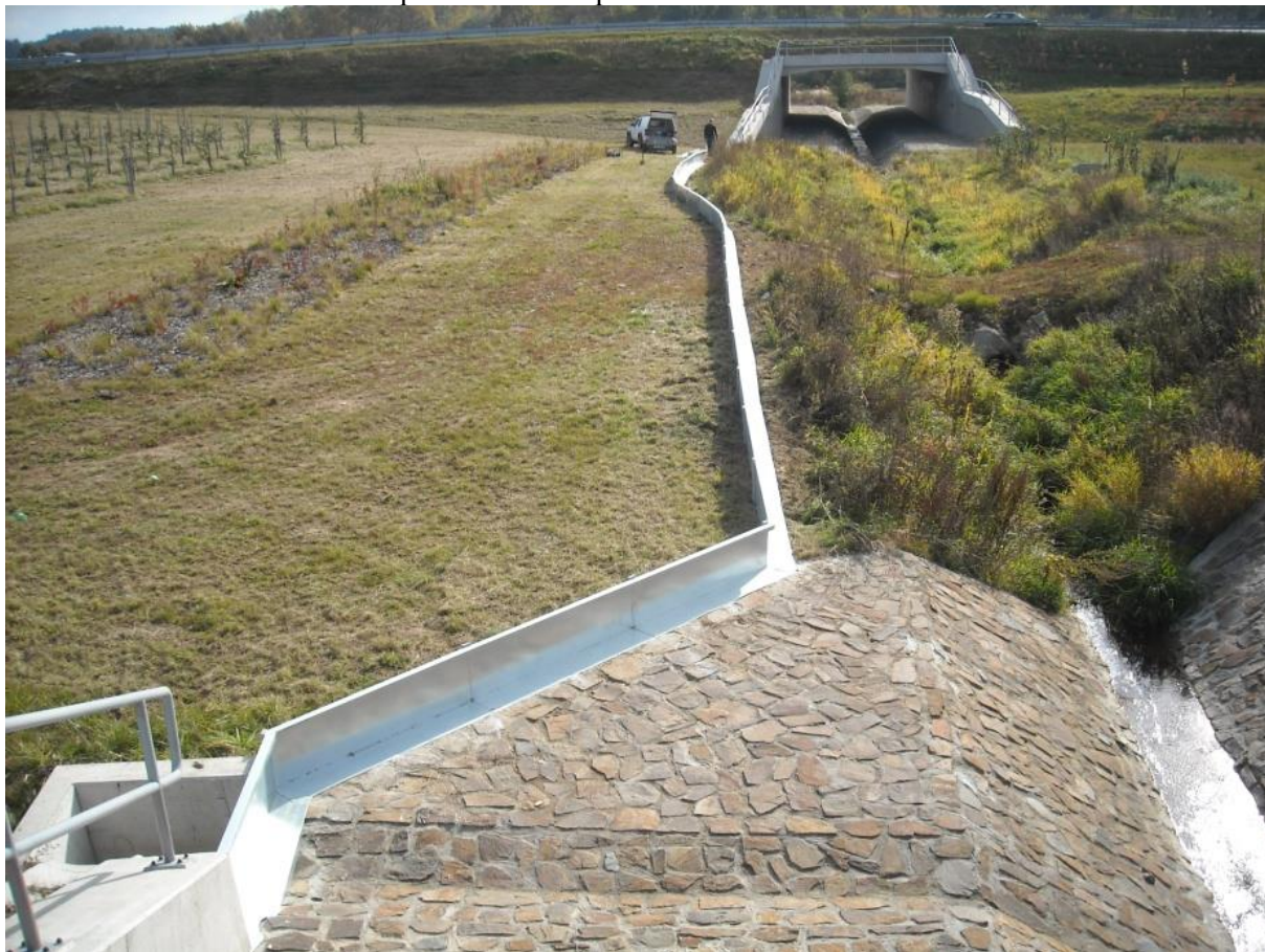
Obrázek č. 5: Instalace dočasné bariéry na stavbě D11 © NaturaServis
