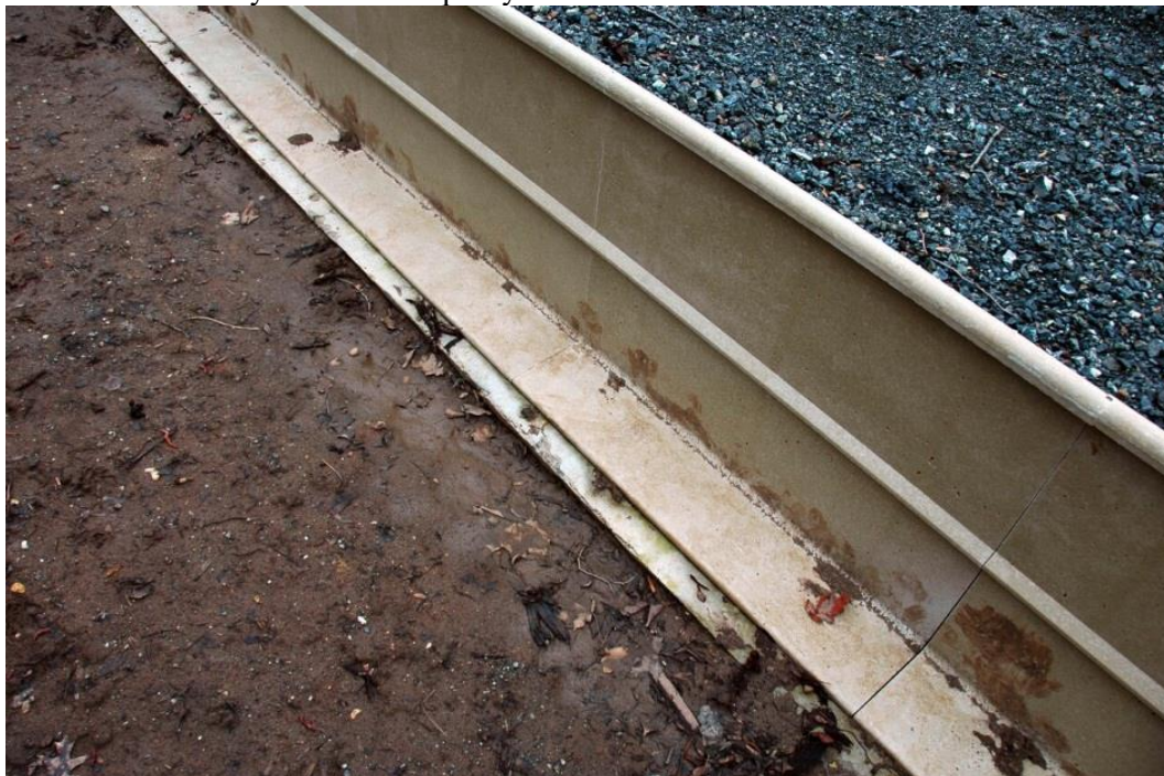
Obrázek č. 3.: Trvalá bariéra z recyklovaného plastu © Roman Rozínek
