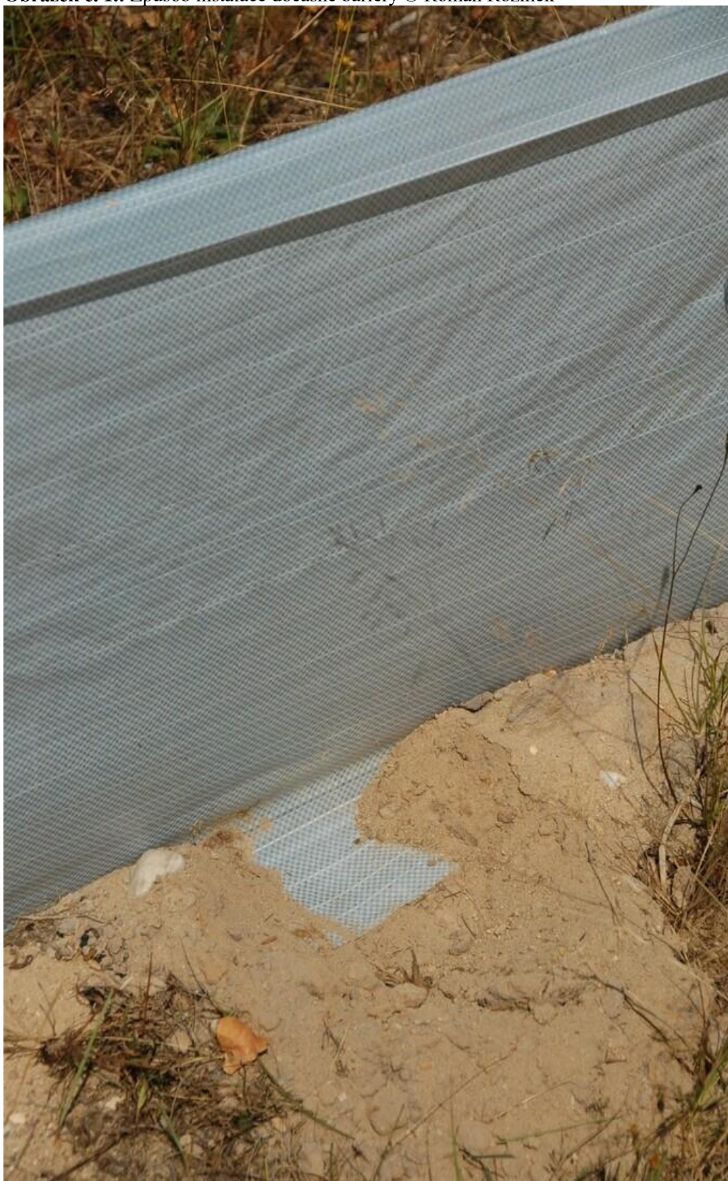
Obrázek č. 1.: Způsob instalace dočasné bariéry © Roman Rozínek
