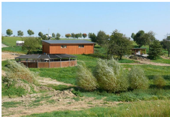
Kolotoč pro koně, hospodářská budova a přístřešek
