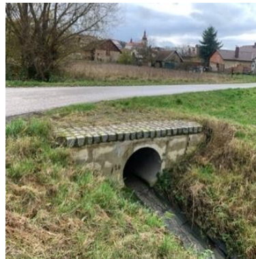
Obr. č. 82: Propustek P6
