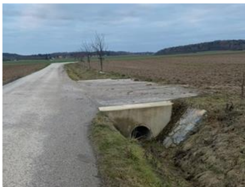
Obr. č. 89: Hospodářský sjezd s propustek na C-14
