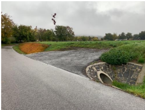
Obr. č. 52: Hospodářský sjezd s propustkem z HC1
