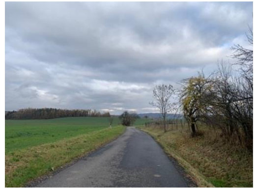
Obr. č. 78: Opravený povrch na C4
