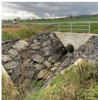
Obr. č. 75: Propustek P4
