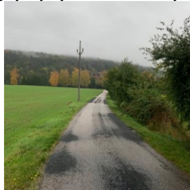
Obr. č. 54: Opravené části vozovky HC2
