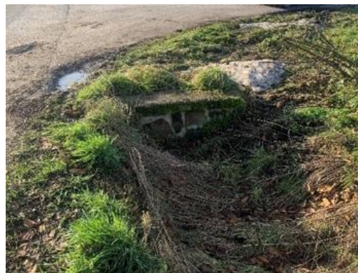
Obr. č. 46: Propustek na křížení C2.5 a C2.6
