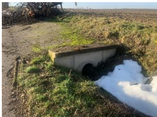
Obr. č. 45: Hospodářský sjezd s propustkem přes P-C2.5
