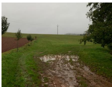
Obr. č. 60: Volné ukončení cesty VC4 do louky s usazenou vodonou
