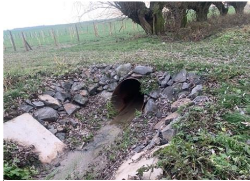
Obr. č. 94: Propustek při C-19
