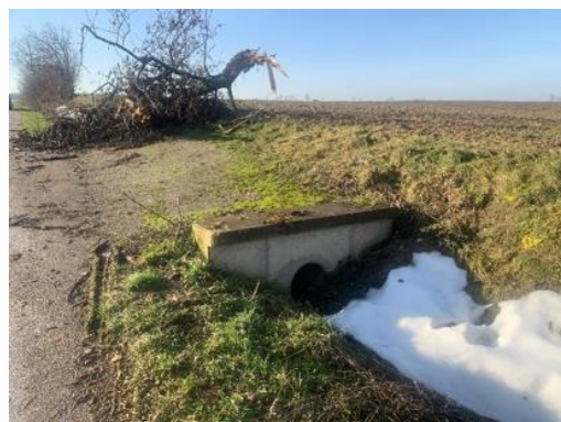
Obr. č. 38: Hospodářský sjezd s propustkem přes P-C2.5
