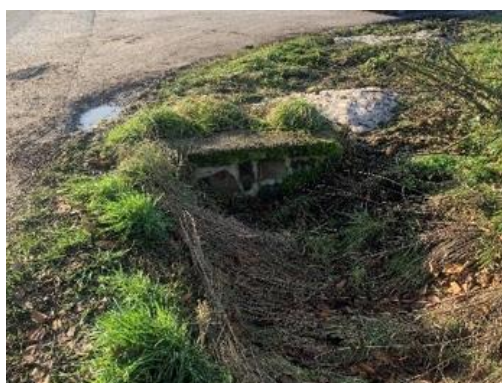
Obr. č. 39: Propustek na křížení C2.5 a C2.6
