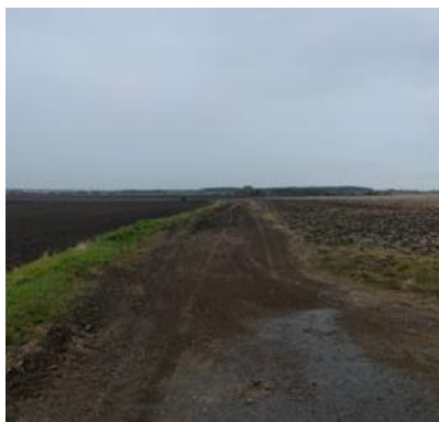
Obr. č. 12: přechod mezi rekonstruovanou a nerekonstruovanou částí HCZS3
