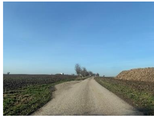
Obr. č. 34: Výhybna na C2.4
