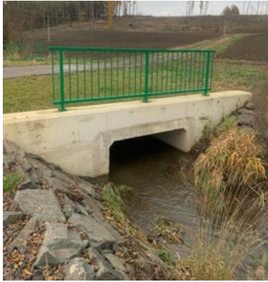
Obr. č. 77: Propustek P5
