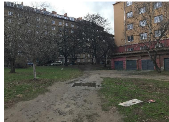
Obr. 55 - Pohled na prostor před garážemi na ulici Dřevařská (foto: autor, 2017)
