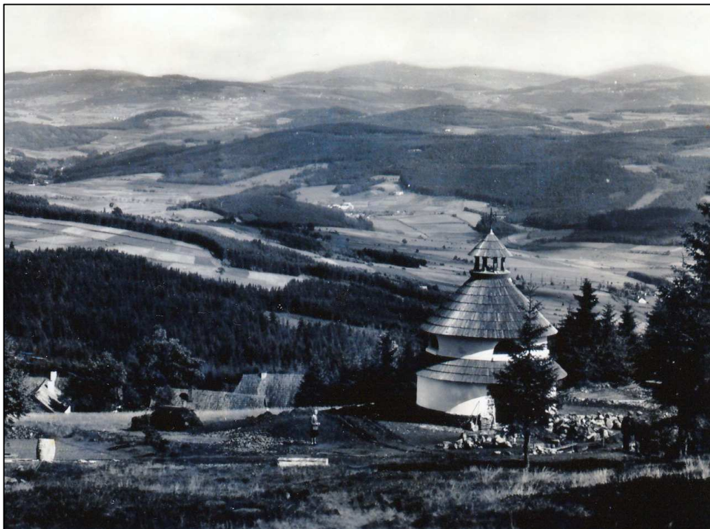
Obr. 26: Javorník – kaple sv. Antonína Paduánského těsně po dokončení, rok 1940.
