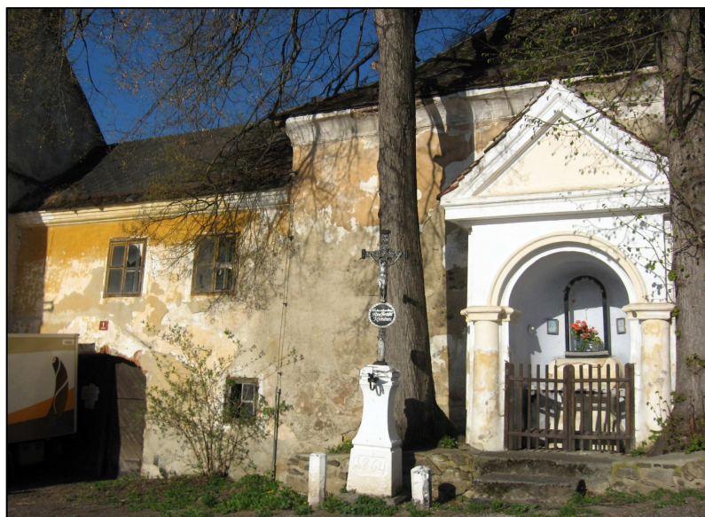
Obr. 14: Přečín – kaple a vstupní brána do zámku, rok 2010.
