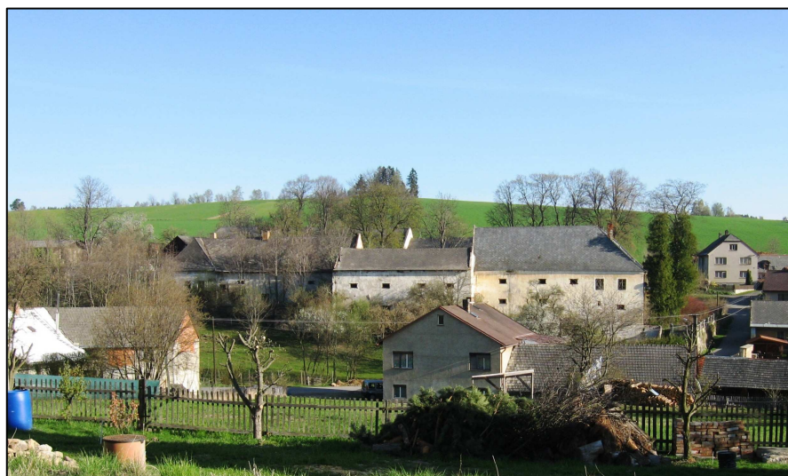
Obr. 13: Přečín – celkový pohled na zámek od jihu, rok 2010.
