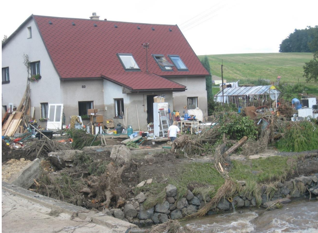
Poničené objekty v obci
