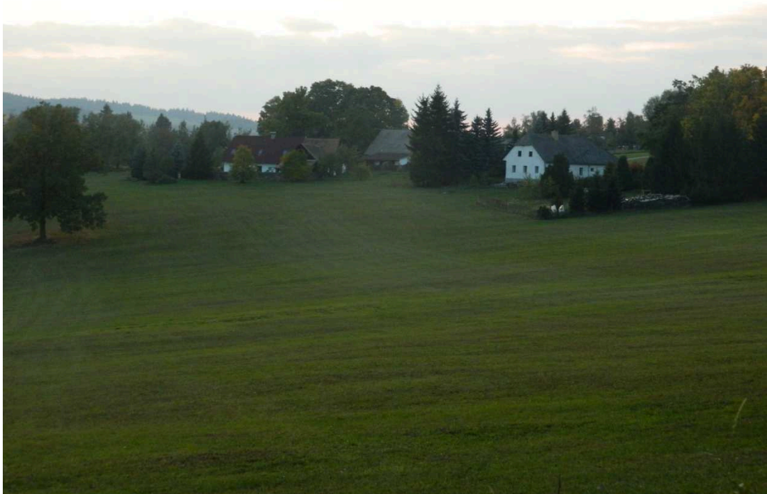
Příloha č. 12: Východní pohled na Škaréz 2 (zdroj: Mikulová, 2017)
