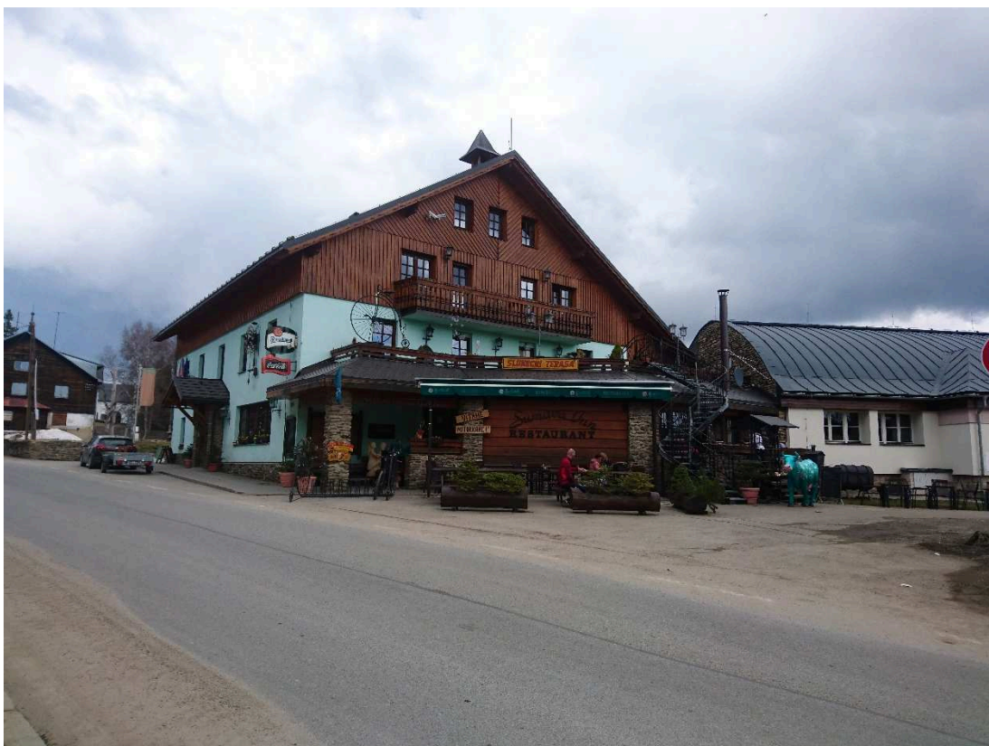
Příloha č. 23: Zdařilá rekonstrukce objektu bývalé Staré hospody na Kvildě (zdroj: Mikulová, 2018)
