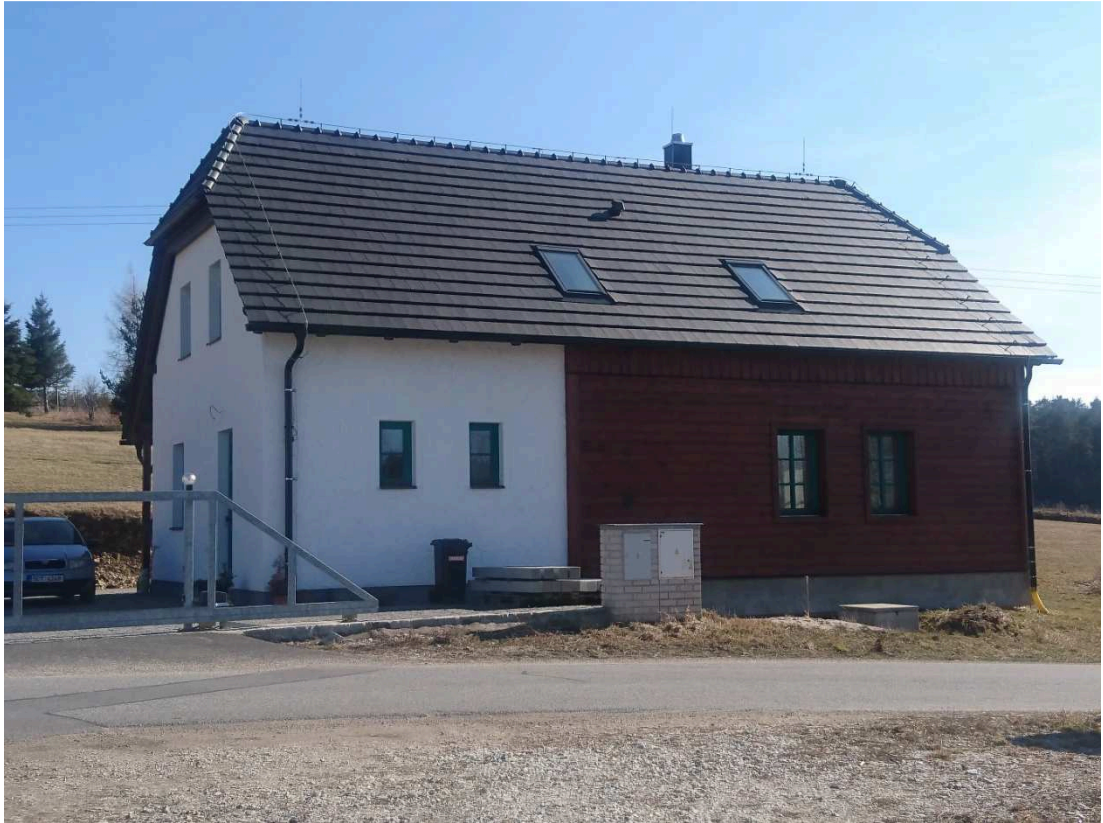
Obr. č. 20: Novostavba rodinného domu číslo popisné 114 (zdroj: Mikulová, 2018)
