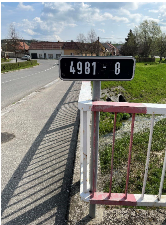
Obrázek 16 – Označení mostu. Zdroj: [vlastní]
