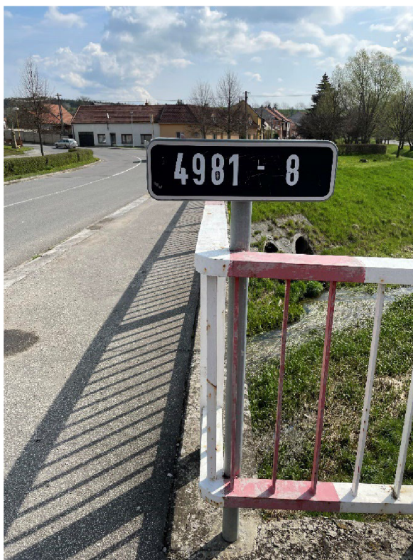
Obrázek 16 – Označení mostu. Zdroj: [vlastní]
