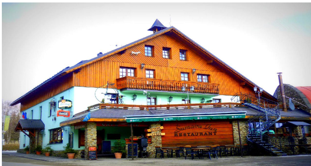
Fotografie č. 9 - Nevhodně volený odstín omítky - pistáciová barva (autorská fotografie)
