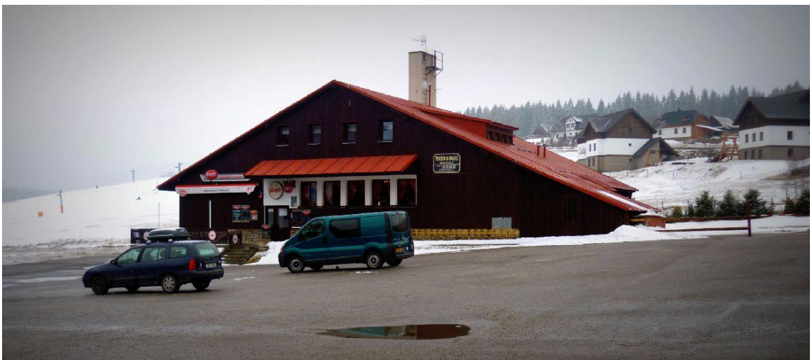
Fotografie č. 8 - Střecha celou plochou přecházející přes objem přístavby (autorská fotografie)
