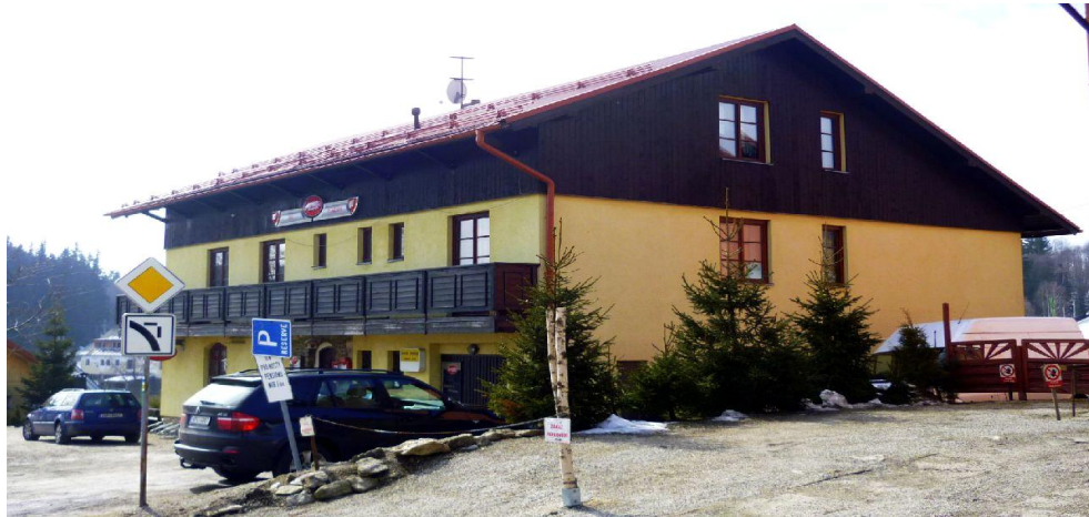
Fotografie č. 7 - Nesprávný sklon střechy menší než 35 stupňů
