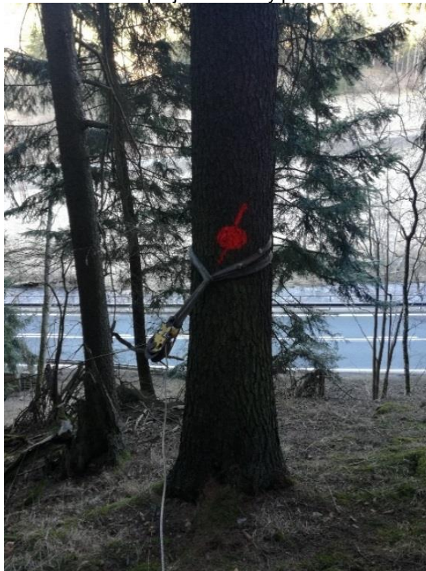
Obr. 6: Označení průjezdné botky pro tažné lano.
