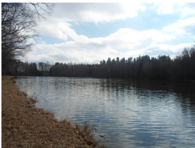
Obr. 21: Malá vodní nádrž Růže (vlastní foto)
