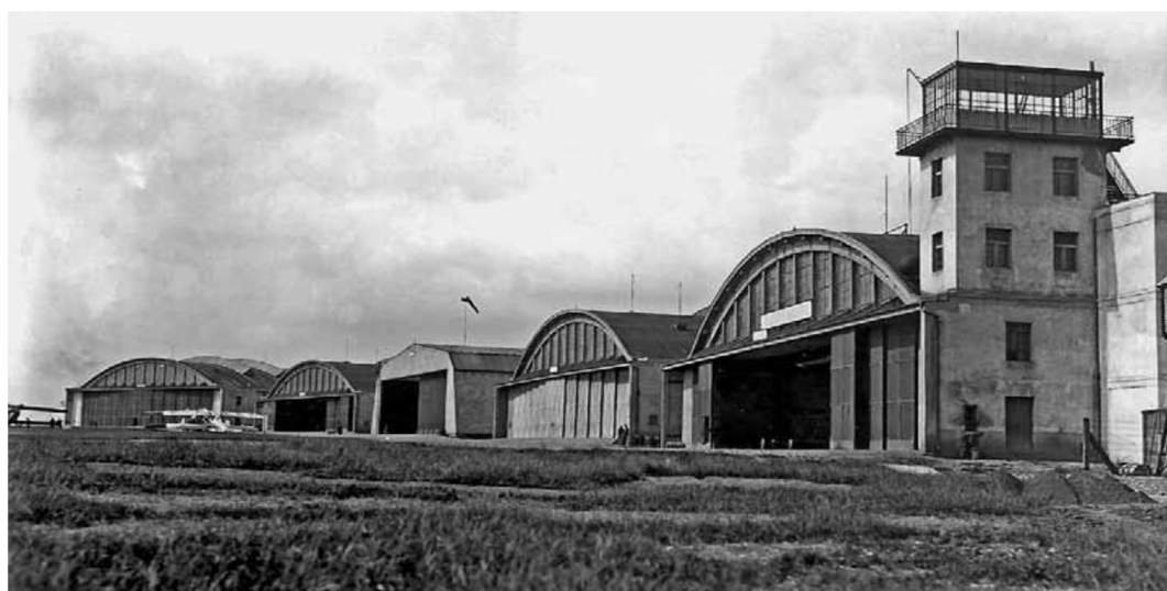
Obrázek 9 Hangáry na civilní části kbelského letiště. dole v době po výstavbě a nahoře současnost. (Matoulek a Soušek, 2009).
