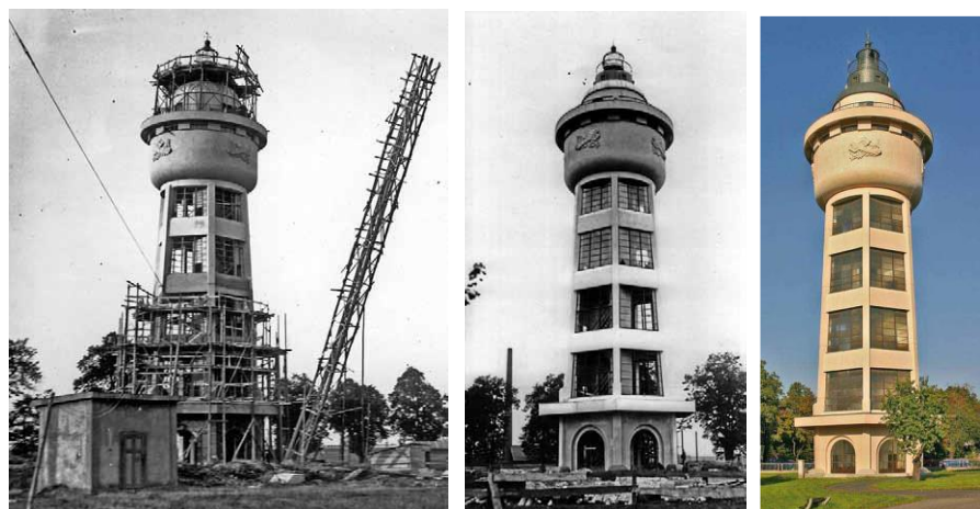
Obrázek 7 Fáze výstavby vodojemu a současnost (Matoulek a Soušek, 2009).
