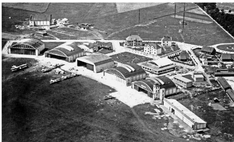
Obrázek 6 Tábor dokončená civilní část letiště (Matoulek a Soušek, 2009).
