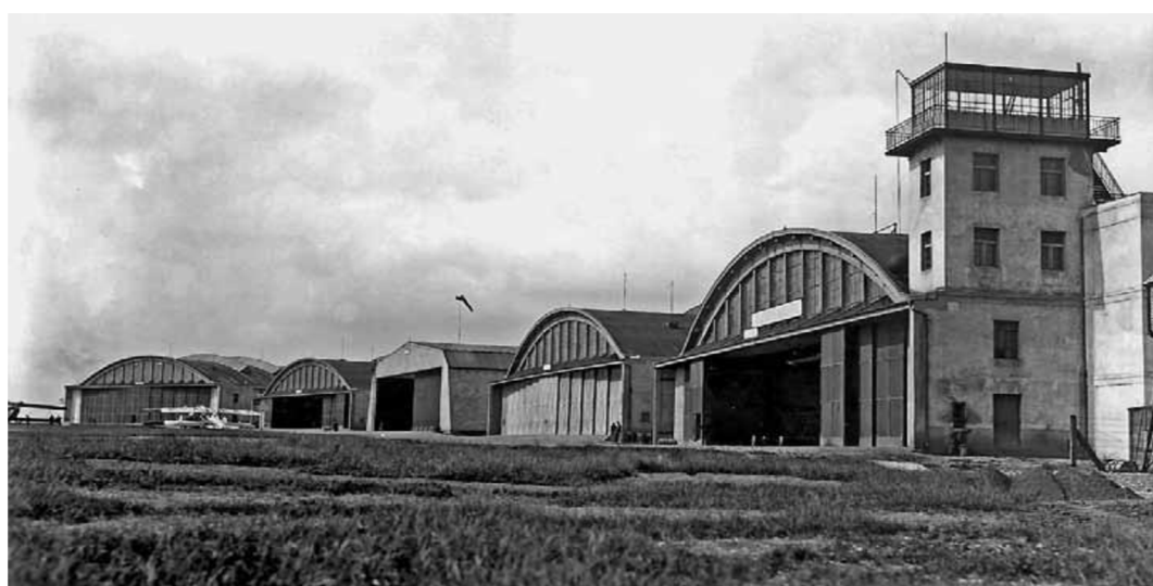
Obrázek 9 Hangáry na civilní části kbelského letiště. dole v době po výstavbě a nahoře současnost. (Matoulek a Soušek, 2009).
