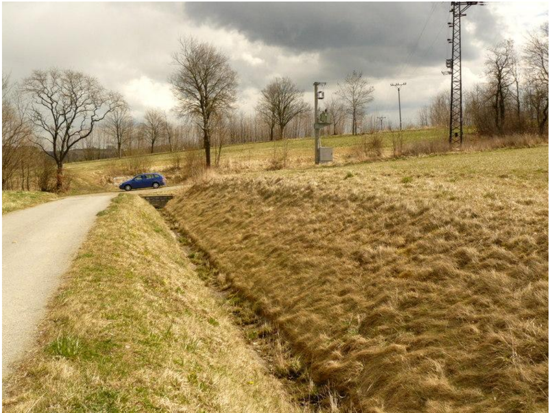
Obr. 3: Pohled na otevřený protipovodňový příkop, zdroj: vlastní
