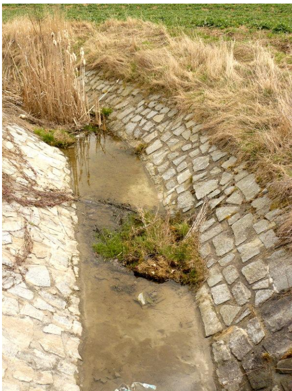
Obr. 9: Pohled na zpevněnou část koryta, zdroj: vlastní
