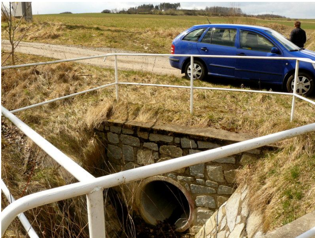
Obr. 4: Detail propustku pod silnicí k Obci Radčice, zdroj: vlastní
