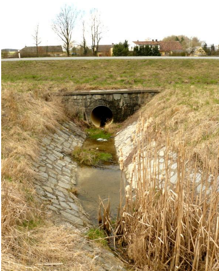
Obr. 8: Pohled na propustek pod silnicí (Vodňany - Protivín), zdroj: vlastní
