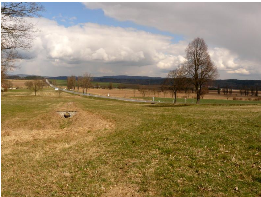
Obr. 7: Pohled na otevřený odvodňovací příkop, zdroj: vlastní
