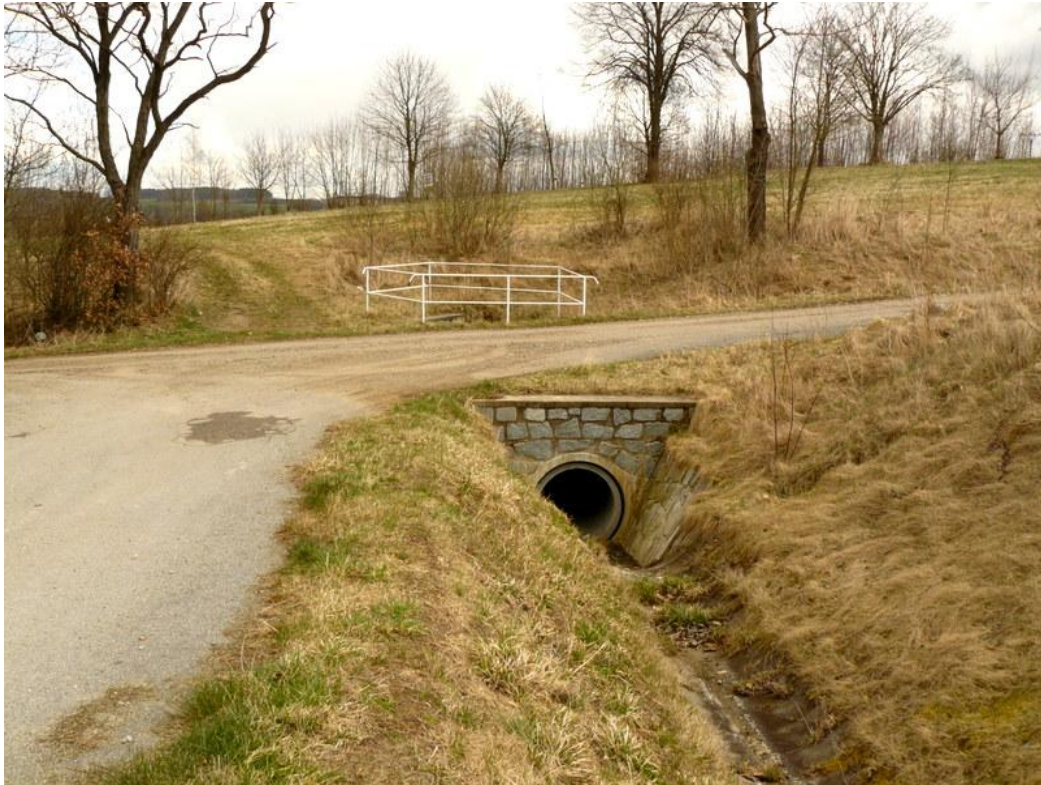
Obr. 1: pohled na propustek pod silnicí k Obci Radčice, zdroj: vlastní
