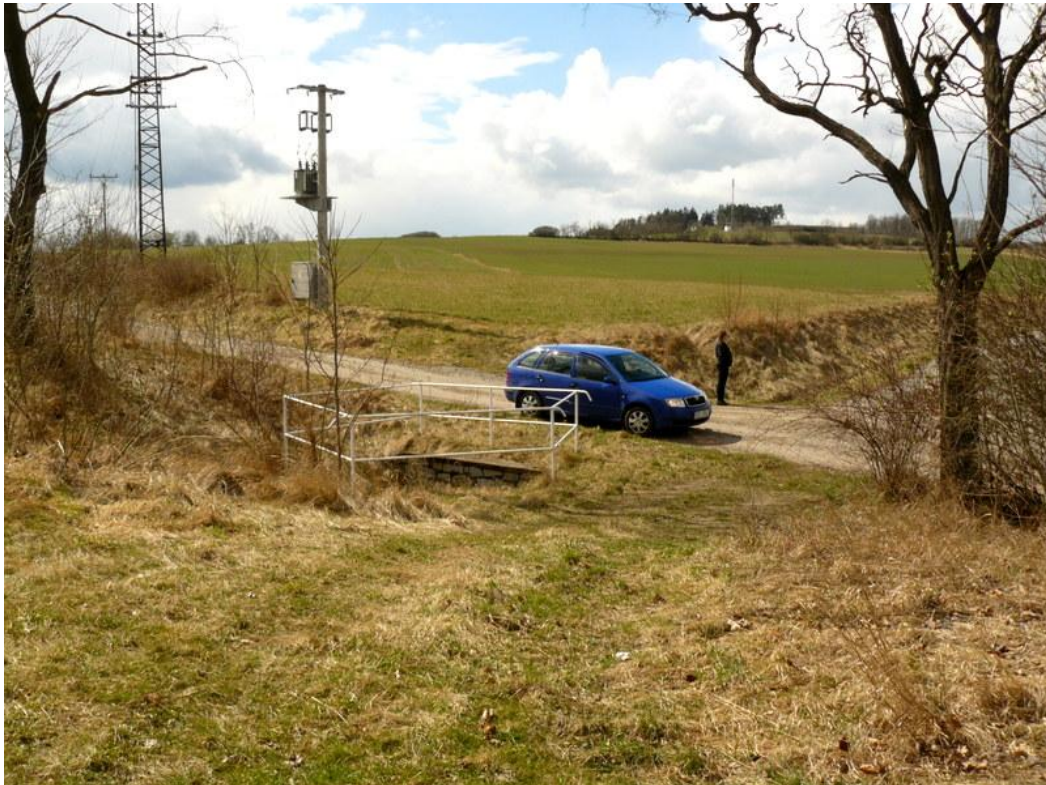
Obr. 5: Celkový pohled na Radčický vrch, otevřený příkop a část zatrubněného k odvedení srážkové vody, zdroj: vlastní
