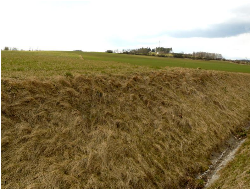
Obr. 2: Pohled na Radčický vrch, otevřený protipovodňový příkop, zdroj: vlastní
