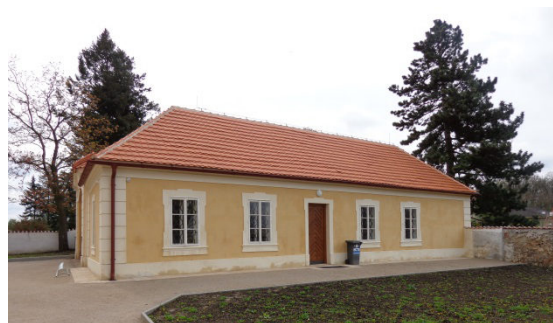
Fotografie 15: Pohled na jednopodlažní administrativní budovu správy parku a zámku.
