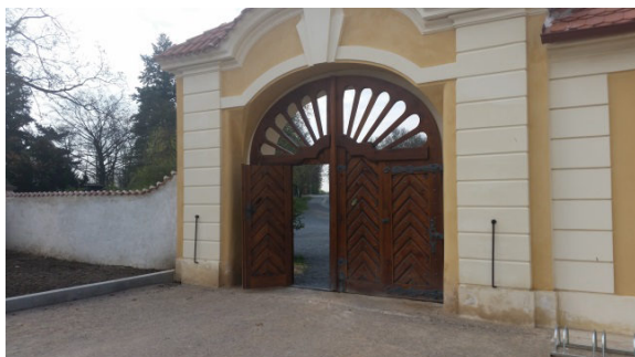
Fotografie 14: Nově zrekonstruovaná vstupní brána přístupná v severozápadní části areálu.
