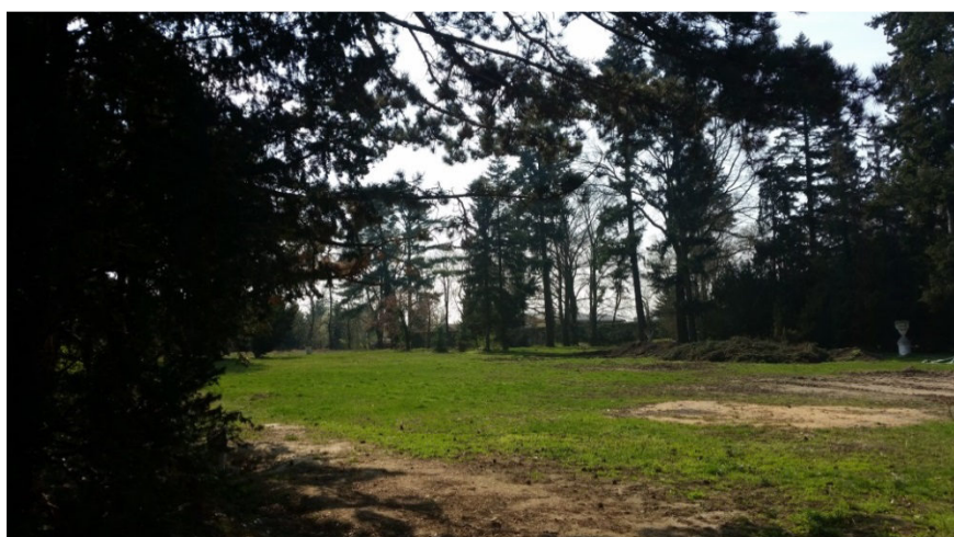
Fotografie 10: Průběh obnovy v polovině listopadu 2016. Navážení a stabilizace svahu mezi zámek, kaplí a ulicí Hlavní. Jižní pohled na spodní část parku.
