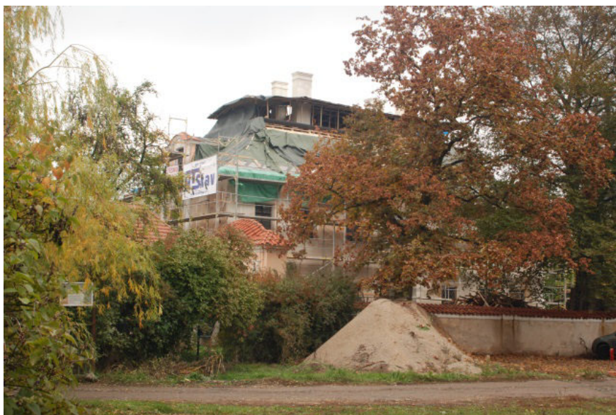
Fotografie 4: Počáteční rekonstrukce zámku a střechy v letech 2015 – 2016. Současně se prováděly hrubé a přípravné práce v interiérech a výměna oken.
