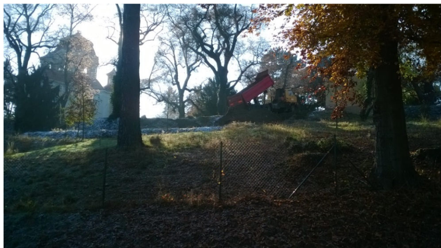
Fotografie 9: Průběh obnovy v polovině listopadu 2016. Navážení a stabilizace svahu mezi zámek, kaplí a ulicí Hlavní. Jižní pohled na spodní část parku.
