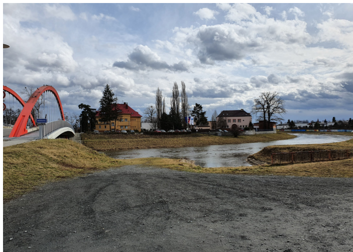
Obr. č. 2: Předpolí mostu
