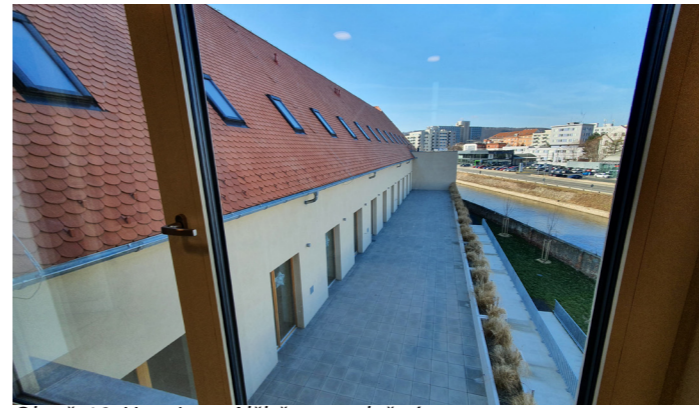
Obr. č. 18: Hospic sv. Alžběty - společná terasa
