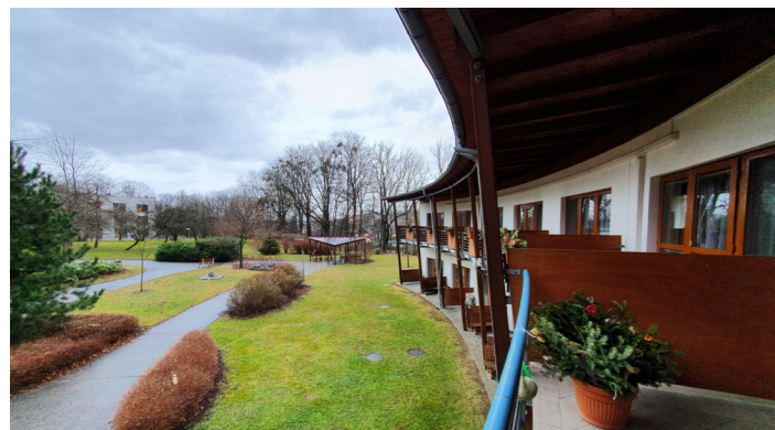
Obr. č. 14: Hospic Citadela - terasy pokojů a altán v parku
