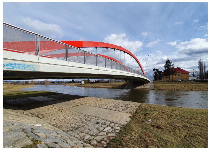
Obr. č. 3: Předpolí mostu
