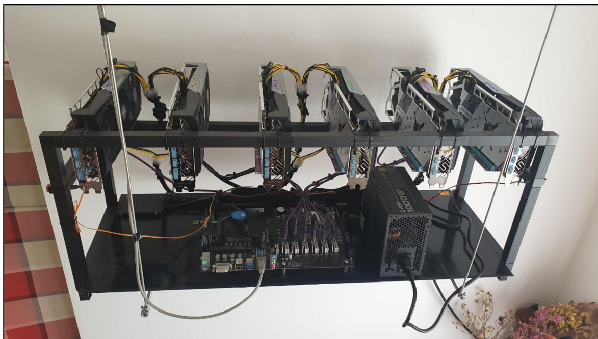
Obrázek 14 Zkoumaný těžební stroj
