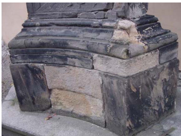
Obr. 55: Žerotínovo náměstí – podstavec jedné ze soch u kostela sv. Michala – práškovatění pískovce
