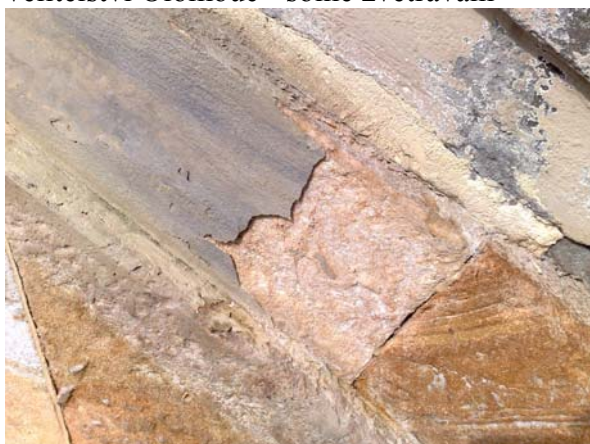
Obr. 47: Budova radnice, Horní náměstí 583. Odlupování krust, práškovatění
