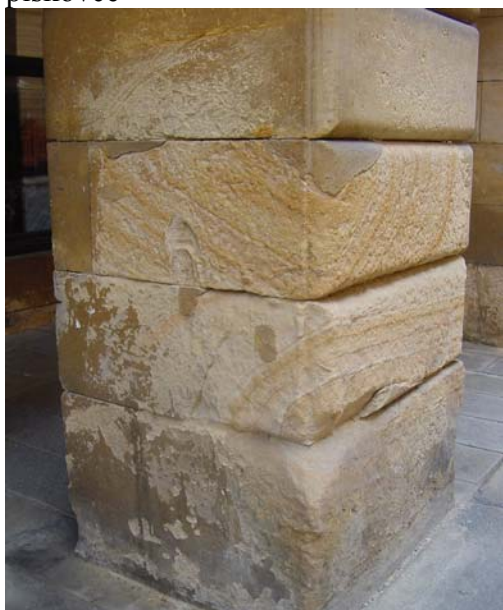
Obr. 67: Horní Náměstí 11, Neoklasicistní Pozemkový úřad (1931), nyní Café Mahler – odlamování klínů sleduje vrstevnatost
