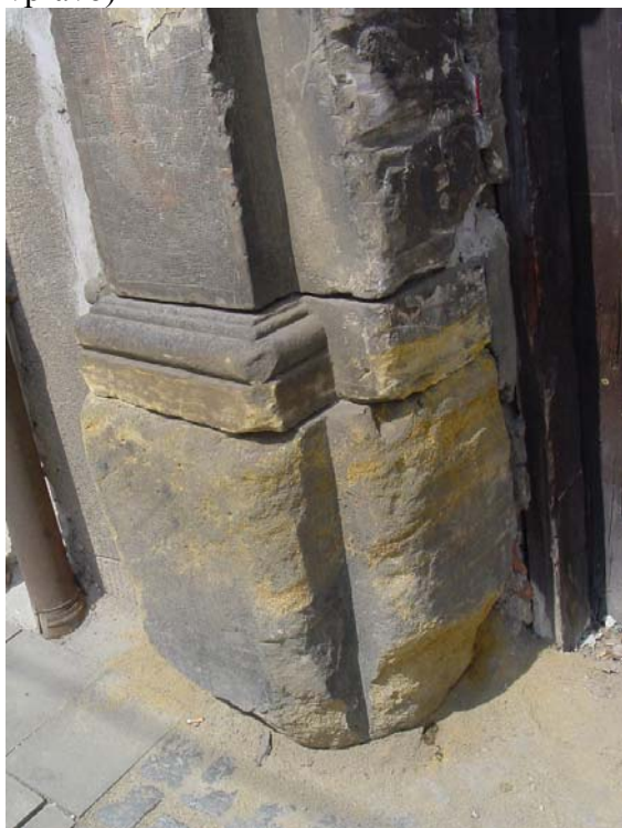
Obr. 75: 1. máje 9 – porovnání odolnosti maletínského (horní část portálu) a žlutého pískovce (moravskoberounské souvrství?)
