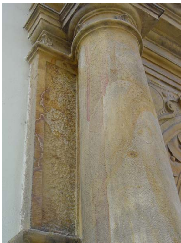
Obr. 58: Křížkovského 2 – sloup z maletínského pískovce s výrazným smouhovitým mramorováním
