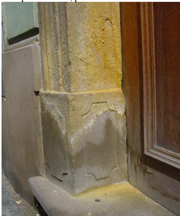
Obr. 49: Michalská 3 (Národní památkový ústav, pracoviště archeologie) – inkrustace dolní části ostění, výrazná degradace nad krustifikovanou částí
