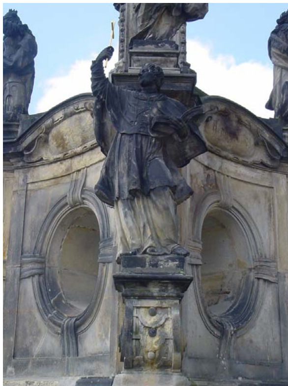
Obr. 60: Morový sloup, Dolní náměstí – barevné změny – pozůstatky čištění louhem
