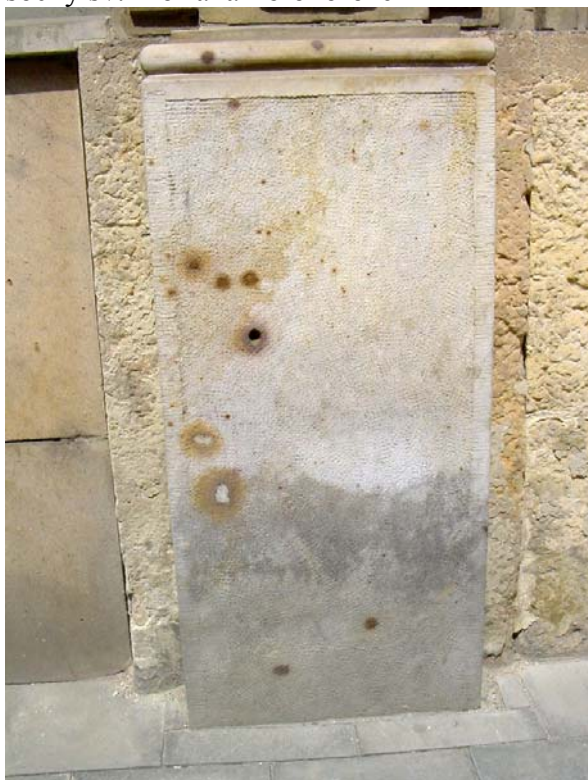
Obr. 71: 1. máje 3, býv. Dům armády – vypadávání „broků“
