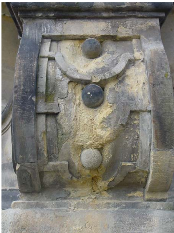
Obr. 61: Morový sloup, Dolní náměstí – detail práškovatění pískovce
