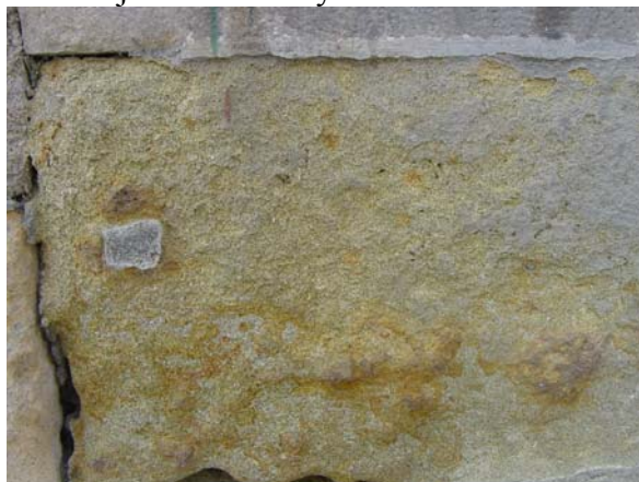
Obr. 66: Nám. Republiky 4 (býv. Jezuitská kolej) - odlamování spolupůsobením vlhkosti a mrazu (podle „broků“ jde o maletínský pískovec
