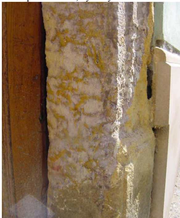
Obr. 50: Michalská 3 (Národní památkový ústav, pracoviště archeologie) – výrazná degradace mrazem
