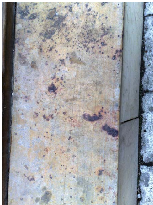
Obr. 72: Barevné skvrny od minerálů Fe – redistribuce Fe z „broků“. Tř. 1. máje
