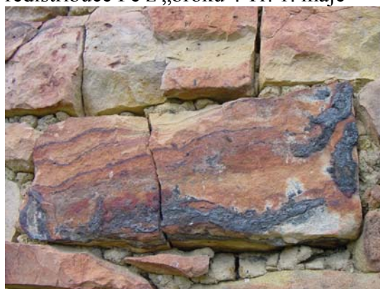
Obr. 74: Degradace vlivem Fe zvětrávání – selský dům v Maletíně
