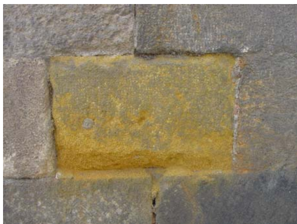
Obr. 64: Správní archiv Armády ČR. Nám. Republiky 4 (býv. Jezuitská kolej). Diferenciální zvětrávání – žlutý pískovec není zřejmě maletínský
