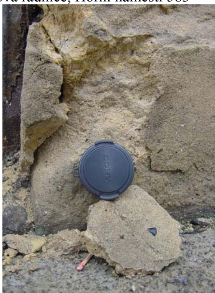
Obr. 54: Horní náměstí č.p.11, Olomouc – vzorek VS2; mrazové poškození
