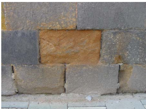
Obr. 63: Správní archiv Armády ČR. Nám. Republiky 4 (býv. Jezuitská kolej) – diferenciální zvětrávání, v nejnižší řadě bloků klínovitě odlamování (frost wedging)
