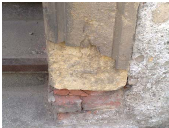
Obr. 78: 1. máje 7 – hluboká koroze z kombinovaného působení soli a mrazu
