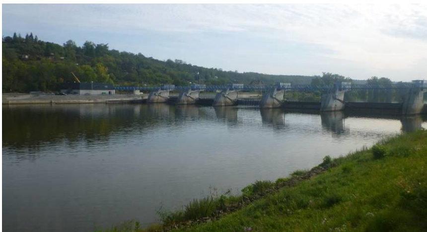
Obr. 7, VD Štětí pohled na MVE a segmentové jezy
