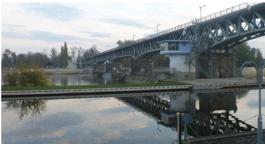
Obr. 8, VD Roudnice n. L. pohled na MVE a hydrostatické sektorové jezy
