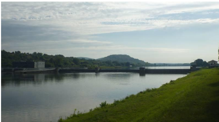
Obr. 9, VD České Kopisty pohled na MVE a hydrostatické sektorové jezy
