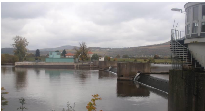
Obr. 10, VD Lovosice pohled na MVE a hydrostatické sektorové jezy
