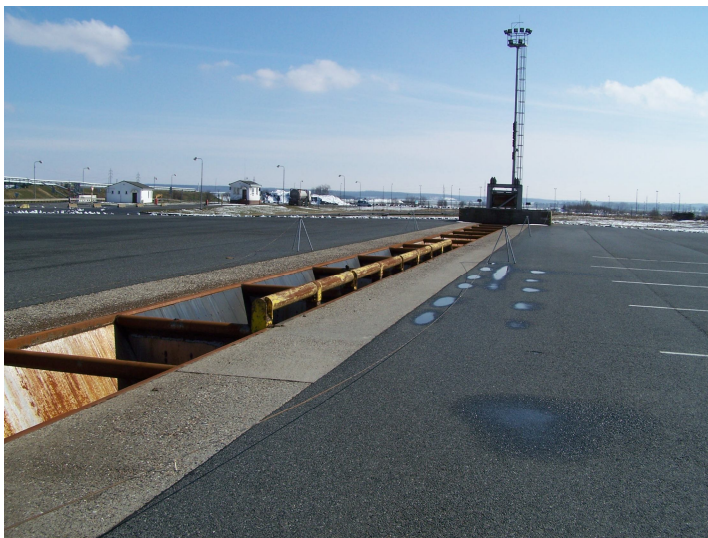
Obrázek 9: Žlab pásového dopravníku se zábranou
