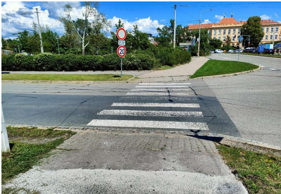
Obr. 27 Stávající stav přechodu pro chodce
