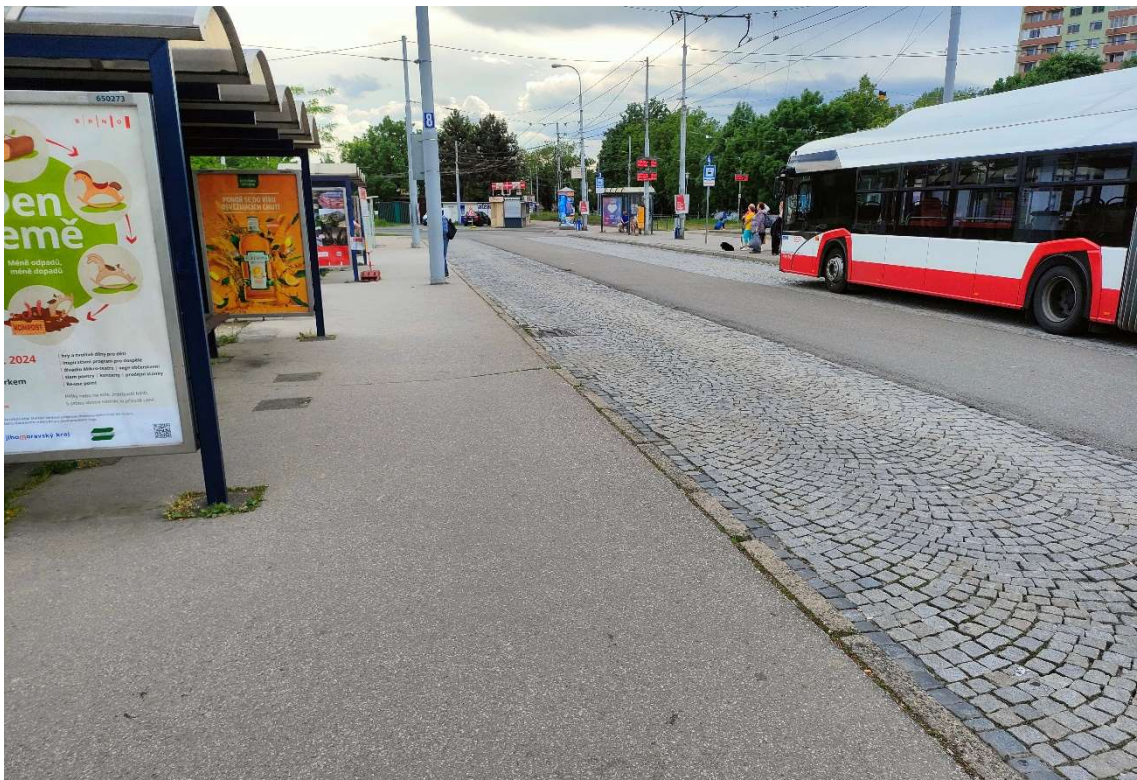
Obr. 10 Chybějící kontrastní pás u nástupní hrany, signální pás u označnicku zastávky
