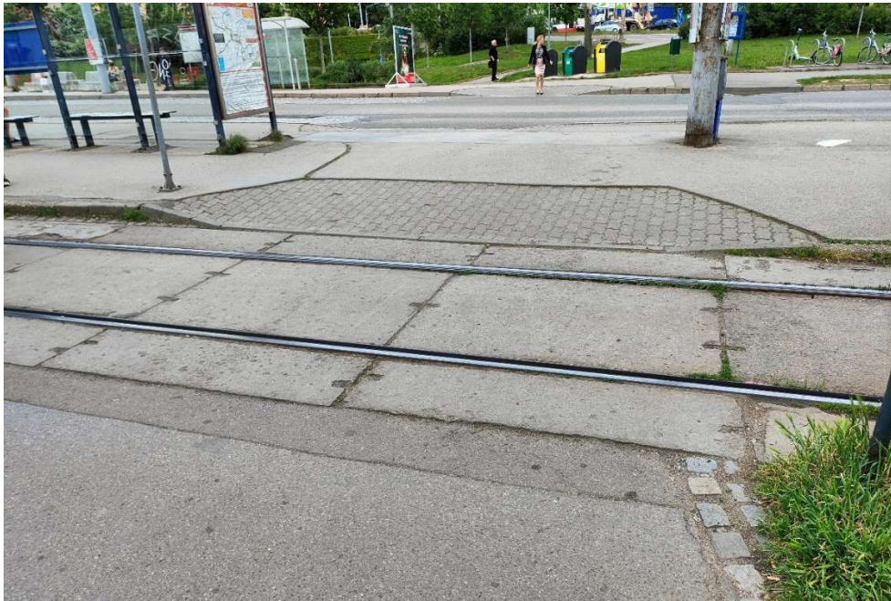
Obr. 20 Stávající stav přechodu tramvajového pásu
