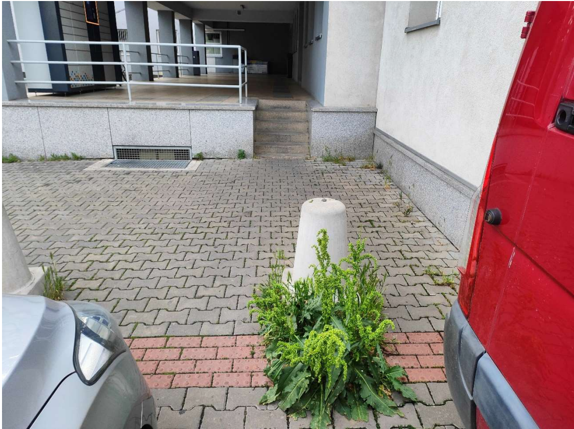
Obr. 17 Nepřístupná nádražní budova
