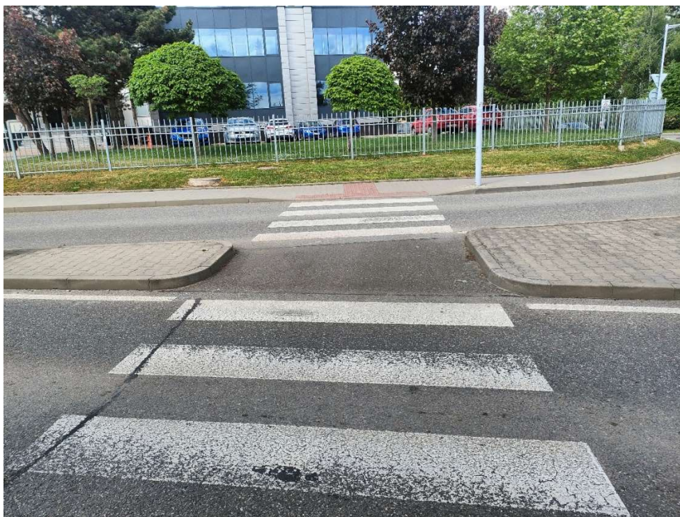
Obr. 38 Stávající stav přechodu pro chodce v ul. Lazaretní
