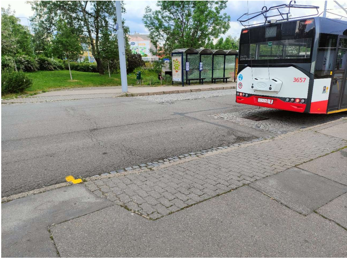
Obr. 11 Chybějící varovný pás, signální pás a vodící pás místa pro přecházení,
