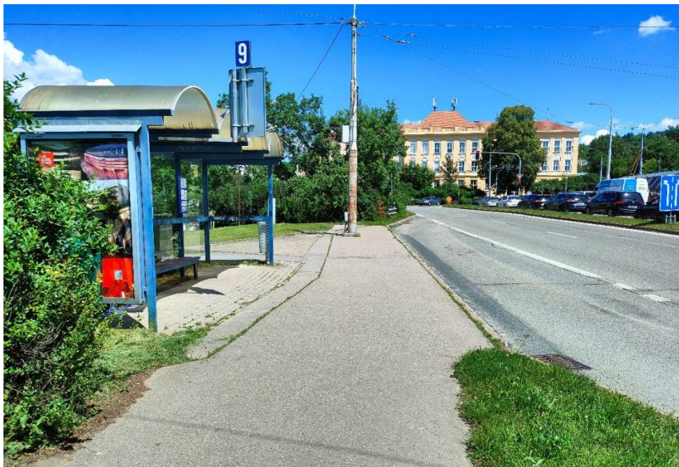
Obr. 29 Stávající stav nástupiště č. 9
