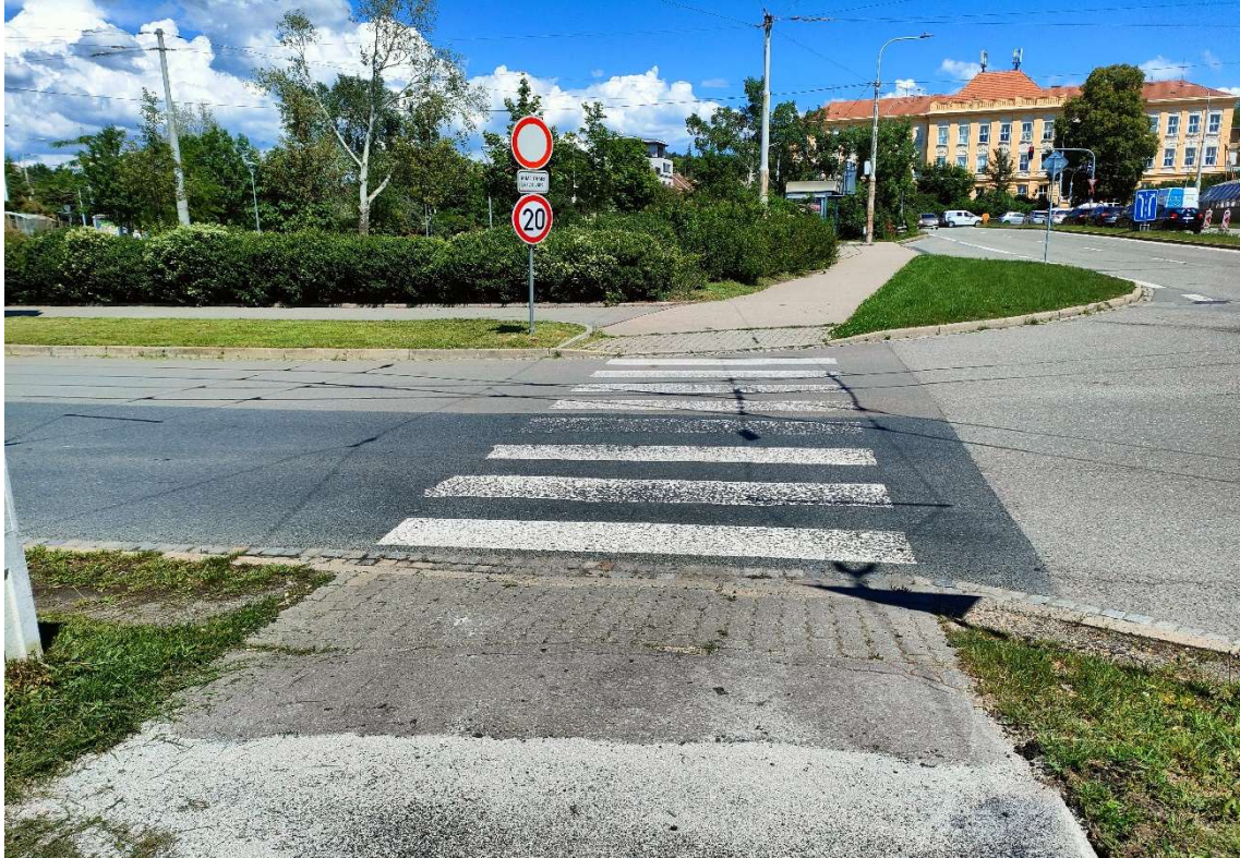
Obr. 12 Chybějící varovný pás a signální pás přechodu pro chodce
