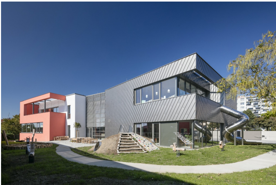
Obrázek 33 Atelier-r, Mateřská škola Nádražní – pohled z jihu, 2018
