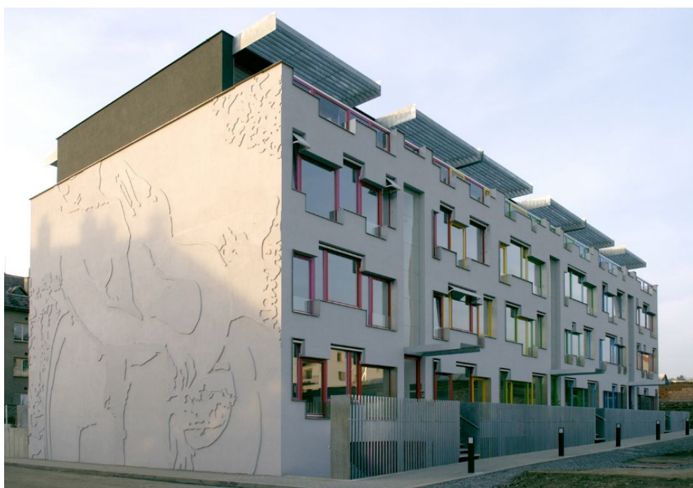
Obrázek 26 Roman Koucký, Bytový dům na Labutí ulici, 2003
