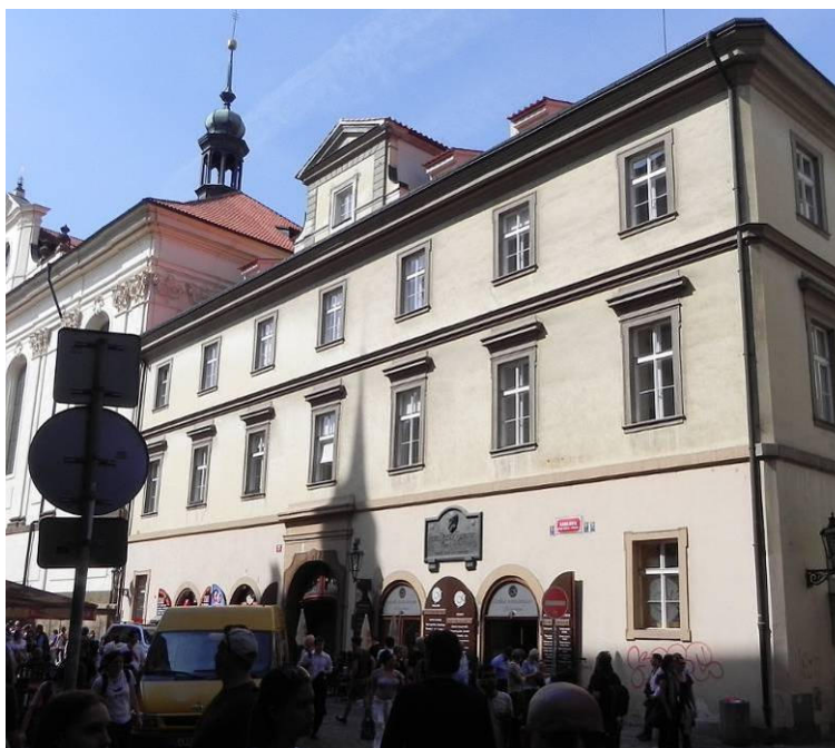
Obr. 12. Jižní průčelí jezuitské tiskárny v areálu Klementina.
