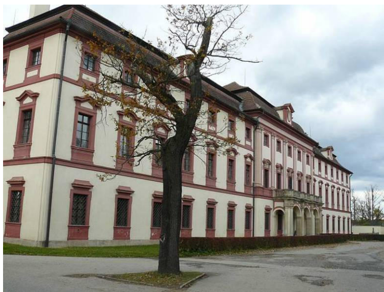
Obr. 15. Hlavní průčelí zámku Ohrada. Pohled z jihovýchodu.
