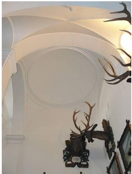
Obr. 25b. Hlavní schodiště. Klenba jižního ramene a jihovýchodní podesty.
