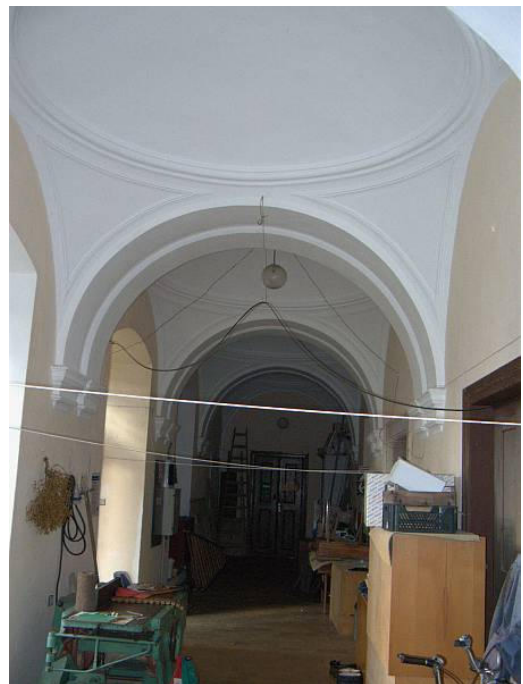
Obr. 22b. Severní část druhotně přepažené chodby severně od vestibulu. Pohled z jihu.
