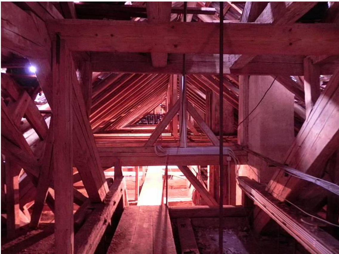
Obr. 36. Krov. Pohled k jihu
