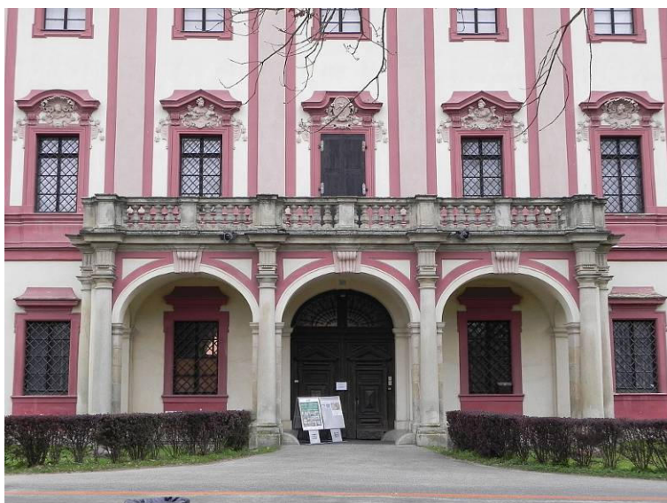
Obr. 16. Portikus hlavního průčelí.
