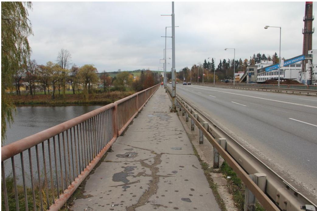
Obr. 12: Pohled na horní část mostu Fráni Šrámka
