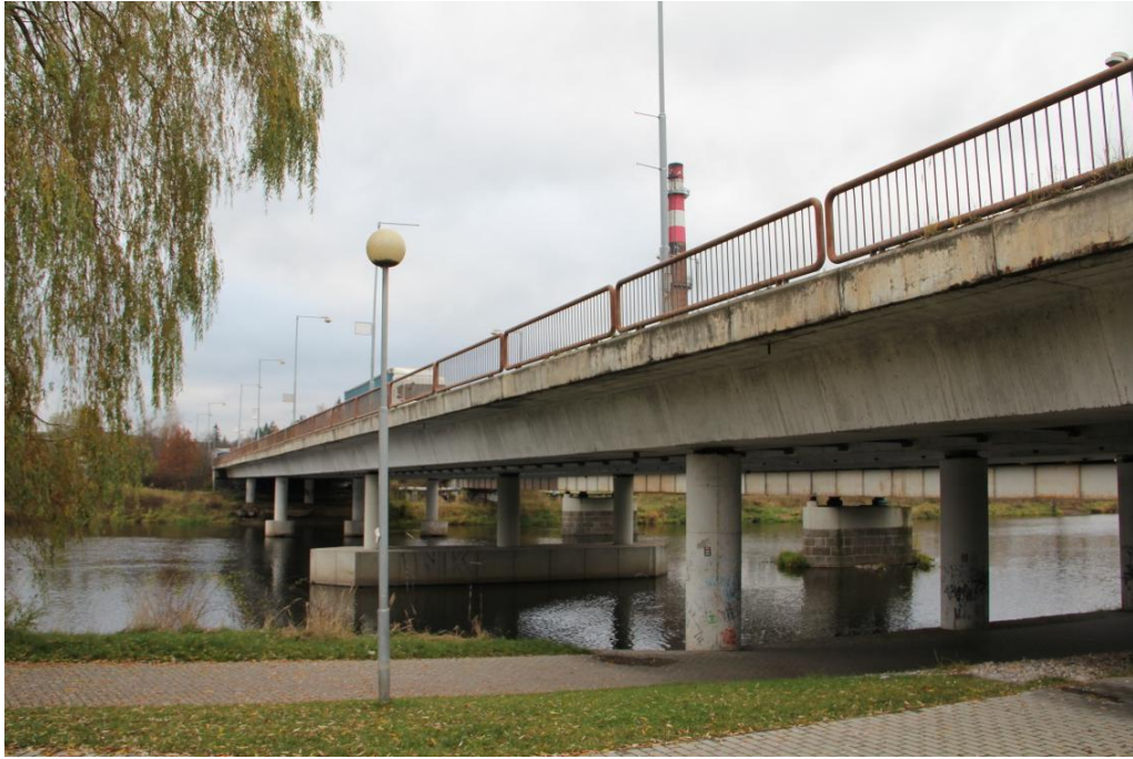
Obr. 11: Pohled na spodní část mostu Fráni Šrámka
