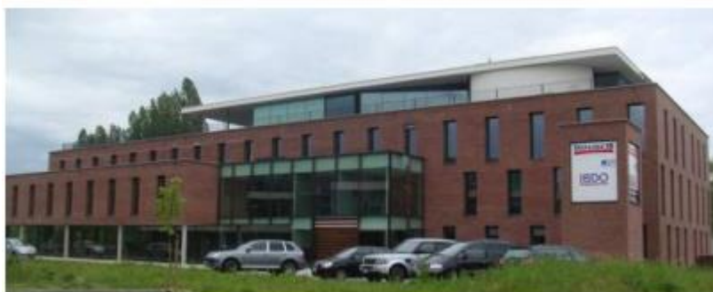
Obr. 3: Budova pro testování MPC v Belgii [4]
