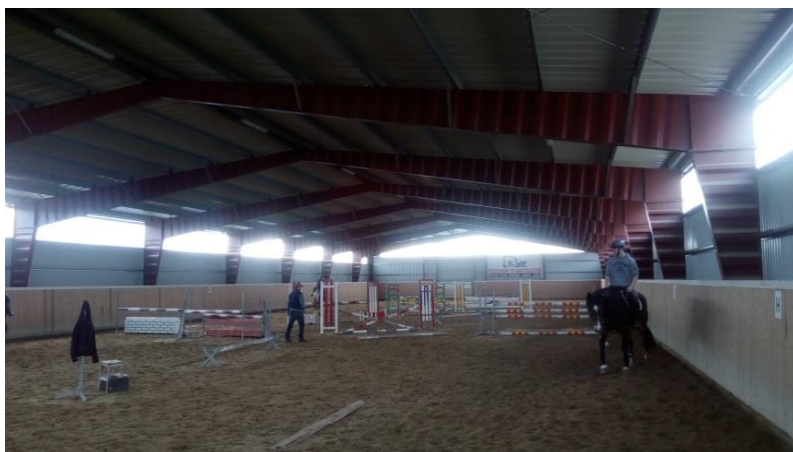
Obr. č. 29: Vnitřní prostor haly s rámovou konstrukcí (zdroj: vlastní)
