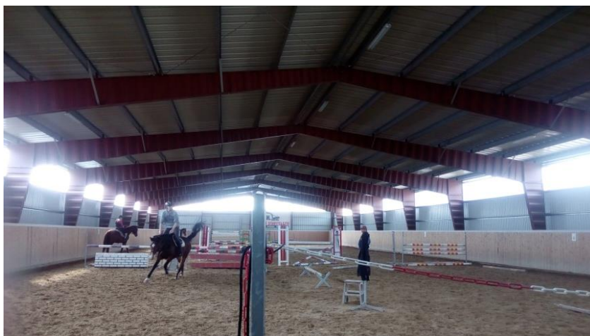
Obr. č. 27: Vnitřní prostor haly (zdroj: vlastní)
