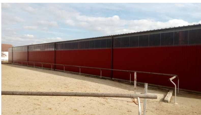
Obr. č. 23: Jezdecká hala a písková jízdárna s ohrazením (zdroj: vlastní)
