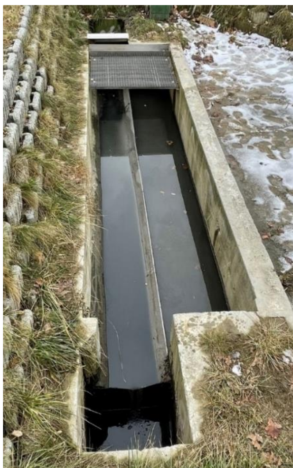
Obrázek 15 Nesprávně navržený lapák písku (ČOV Závada)
