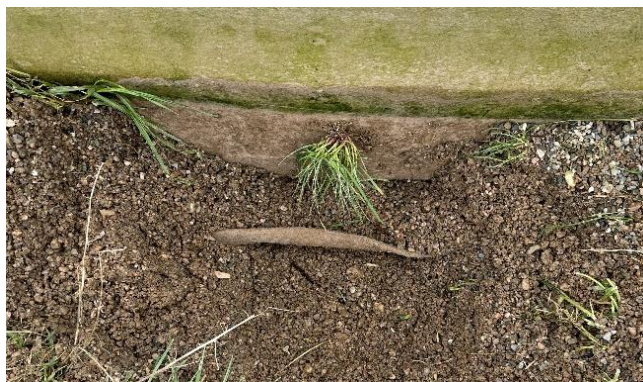
Obrázek 22 Založení filtračního lože (ČOV Závada)
