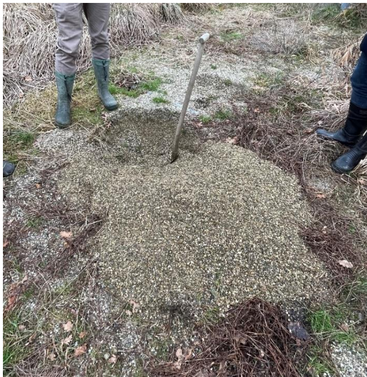
Obrázek 28 Špatné nahrazení písku štěrkem v druhém filtru (ČOV Závada)
