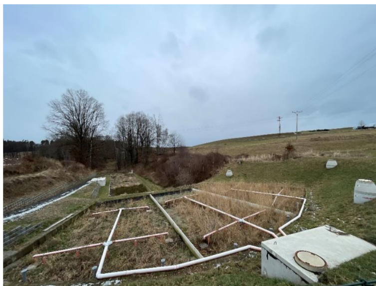
Obrázek 18 Pohled na první filtr a distribuční šachtu s rozvodným potrubím (ČOV Závada)
