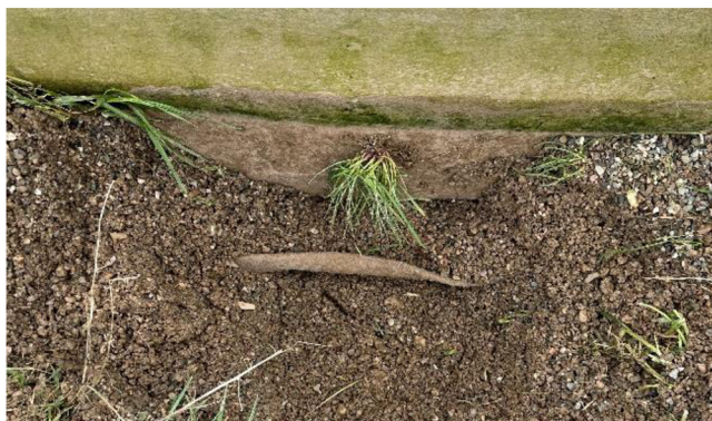
Obrázek 22 Založení filtračního lože (ČOV Závada)
