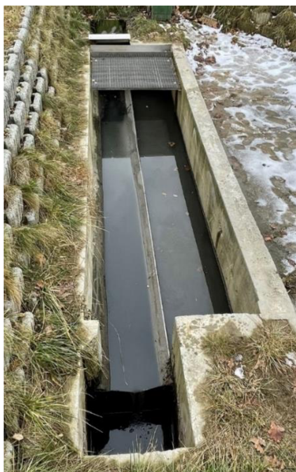
Obrázek 15 Nesprávně navržený lapák písku (ČOV Závada)
