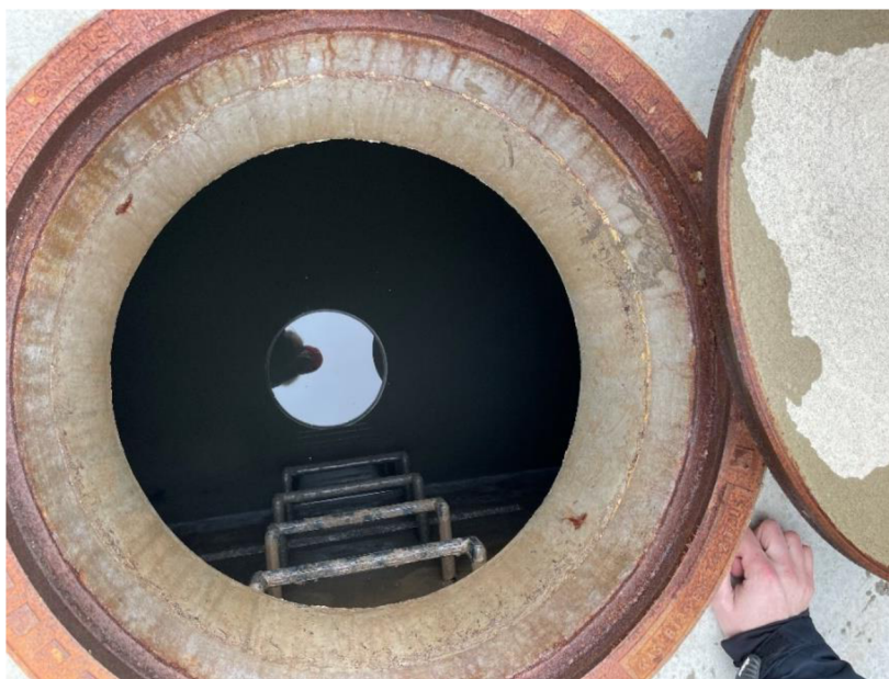
Obrázek 25 Pohled do distribuční šachty druhého filtru (ČOV Závada)
