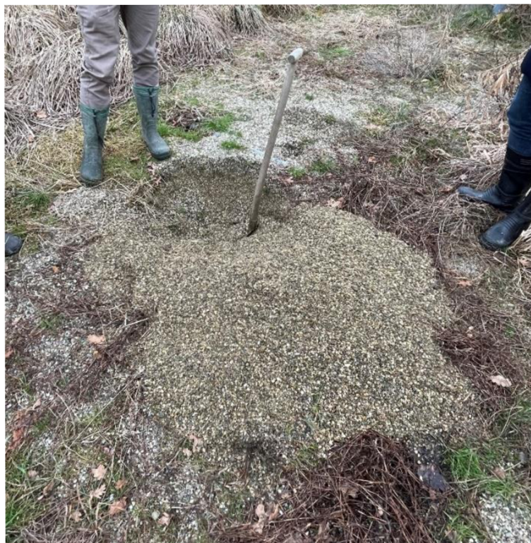
Obrázek 28 Špatné nahrazení písku štěrkem v druhém filtru (ČOV Závada)
