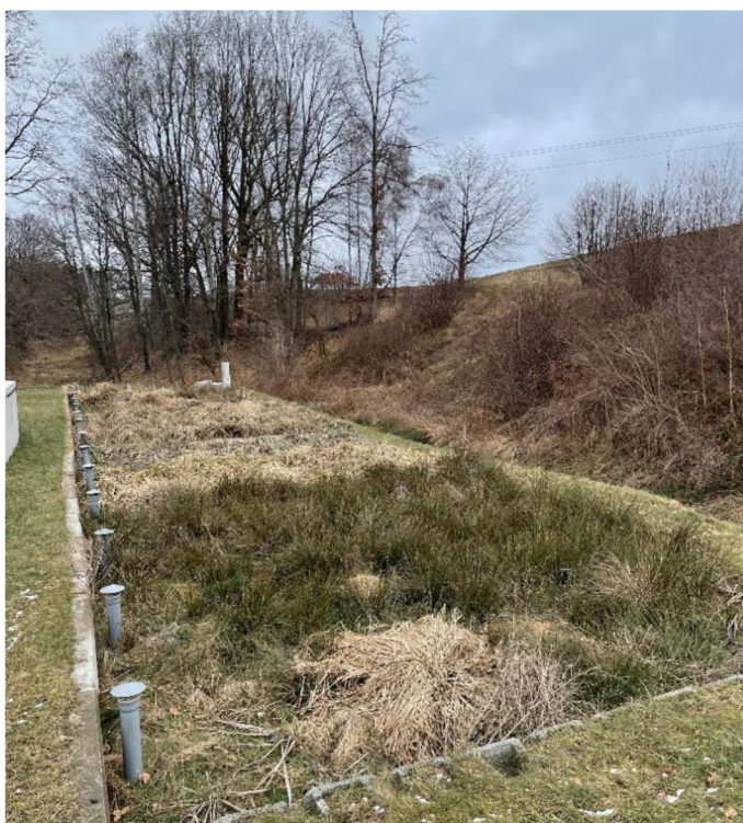
Obrázek 26 Druhé filtrační pole (ČOV Závada)
