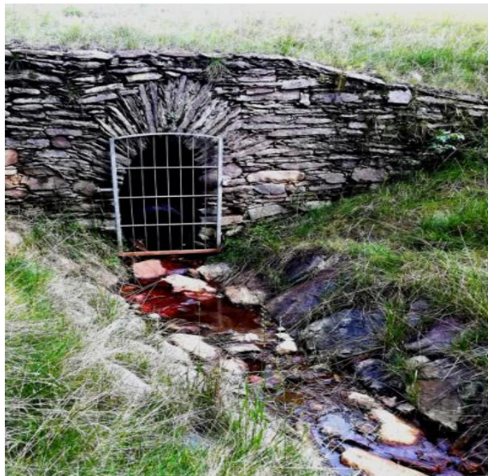
Obrázek 5: Ústí štoly Eduard pod hrází Heinzova rybníka (AUTOR, 2019).
