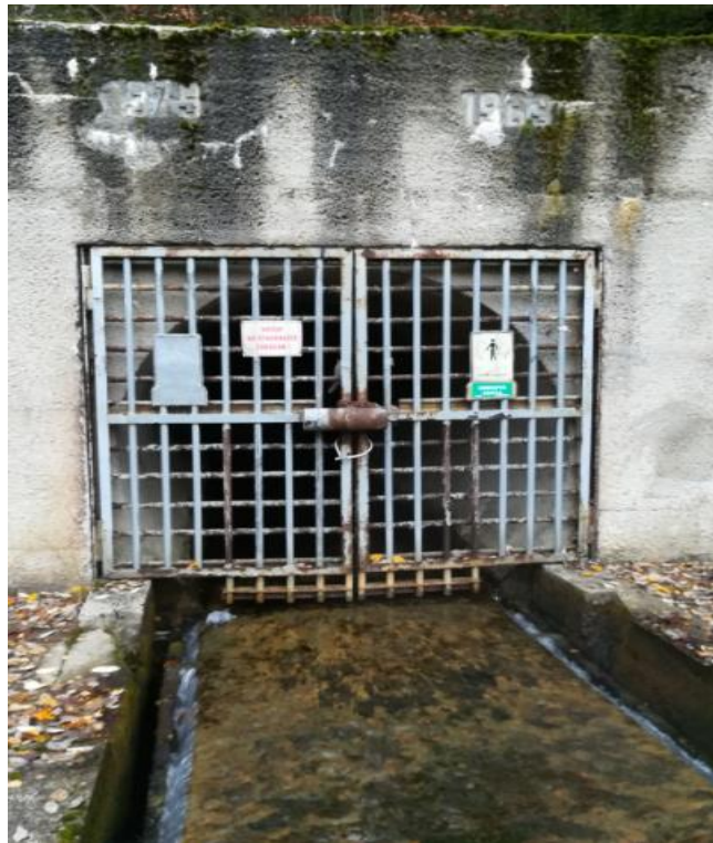
Obrázek 6: Ústí štoly Nová Svornost s betonovou odvodňovací stokou (AUTOR, 2019).
