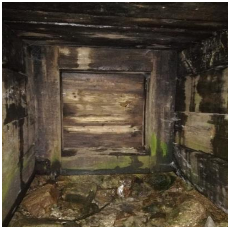
Obrázek 4: Vavřinec odvodňovací štola (AUTOR, 2019).
