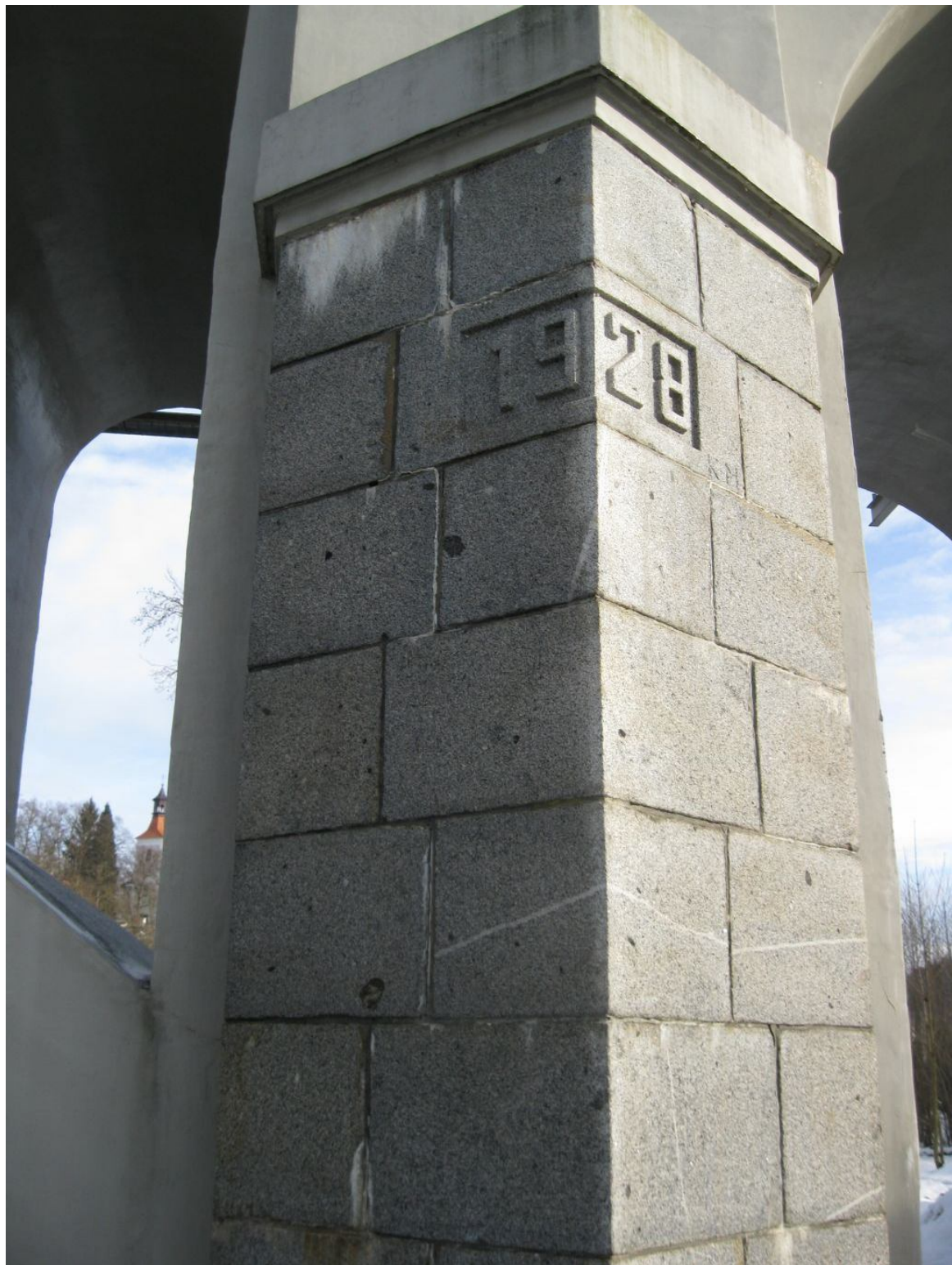
Obr. č. 9 Pilíř mostu s letopočtem jeho postavení
