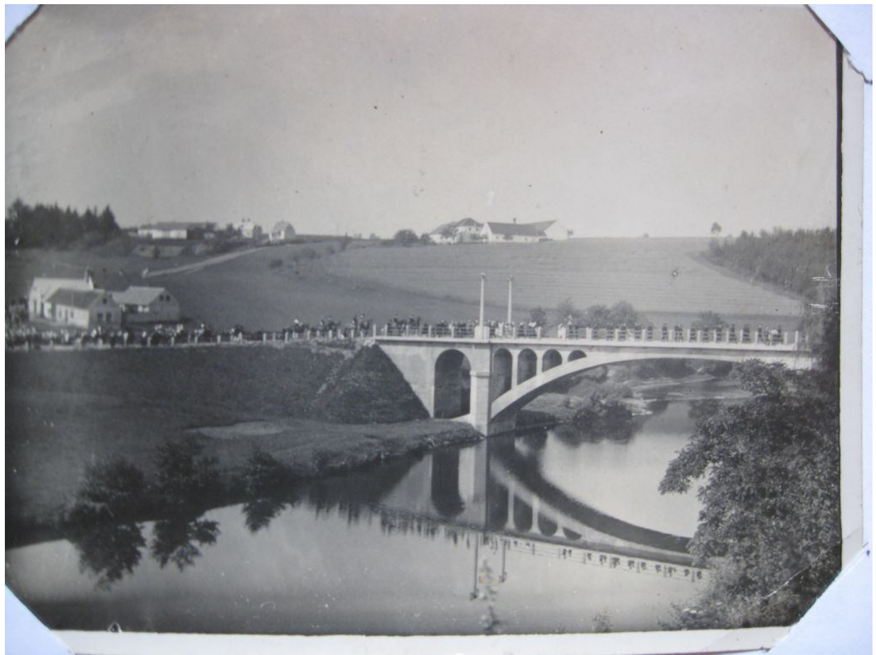
Obr. č. 8 Nový most po dokončení
