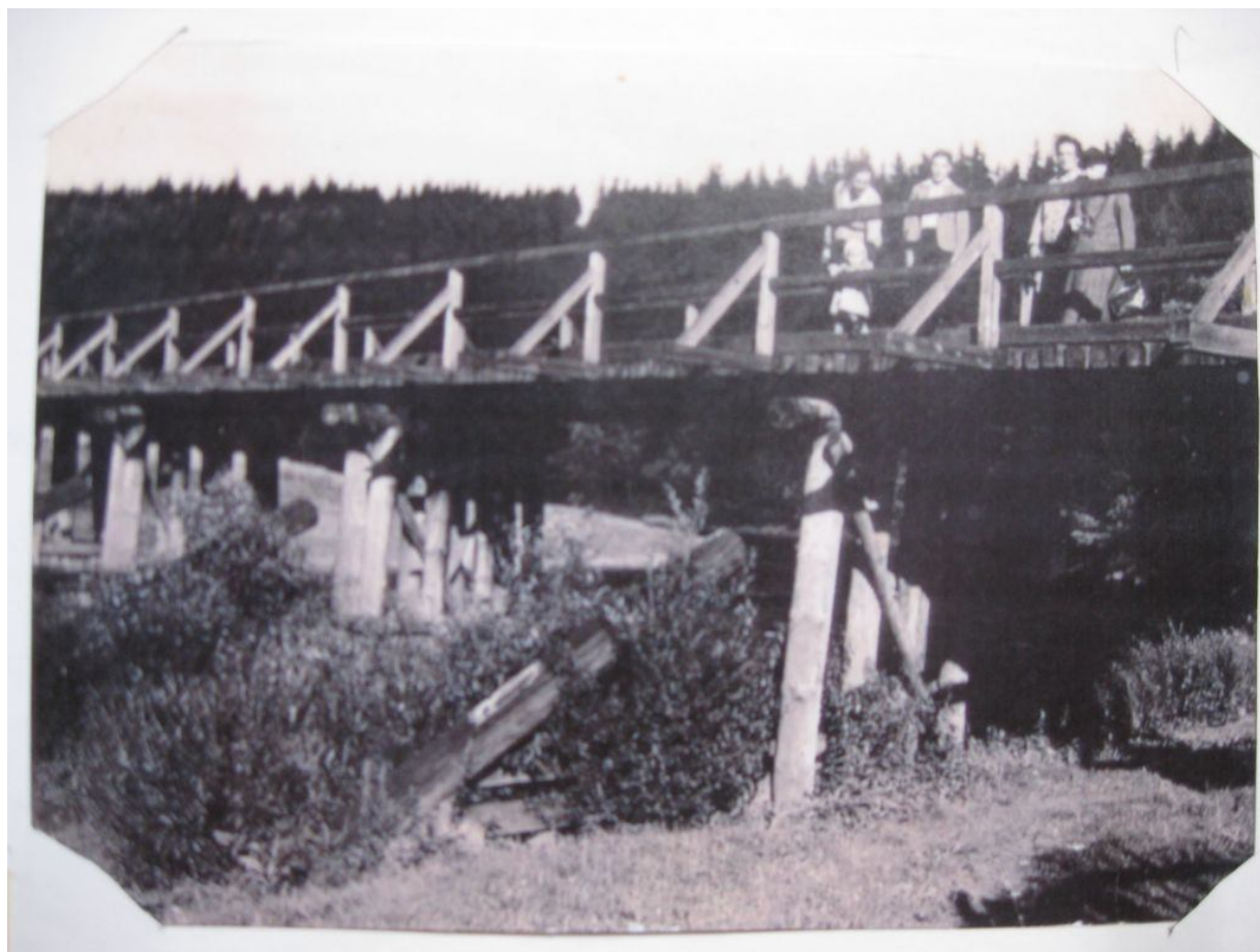
Obr. č. 11 Lávka „u Žočků“ která byla postavena současně s betonovým mostem
