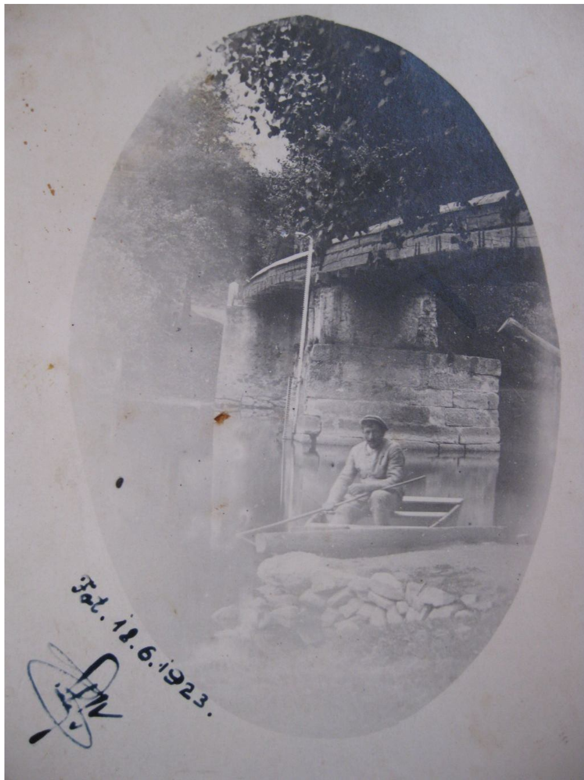
Obr. č. 4 Pohled na starou lávku od jejího pilíře
