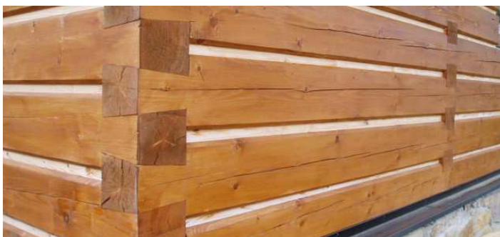
Obr. 4: Roubená konstrukce z opracovaných hranolů – tzv. „rybina“ [3]
