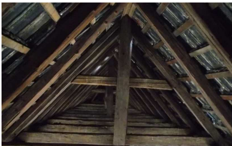
Příloha 1 Třetí patro krovové konstrukce v chrámové lodi
