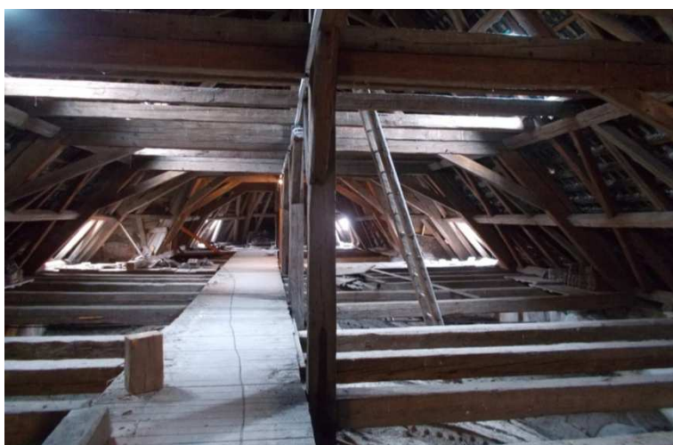
Příloha 3 První patro krovové konstrukce v chrámové lodi
