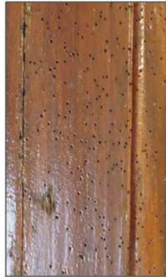
Příloha 24 Dveře do sakristie – napadeno červotočem
