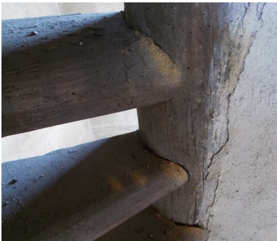
Příloha 30 Točité schodiště na ochoz – aktivní napadení dřevokazným hmyzem
