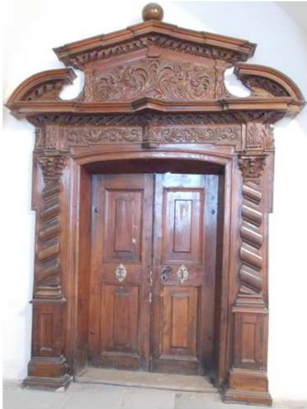
Příloha 24 Dveře do sakristie – napadeno červotočem
