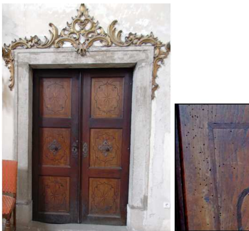
Příloha 23 Dveře do presbytáře – napadeno červotočem
