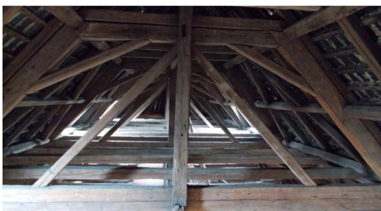
Příloha 2 Druhé patro krovové konstrukce v chrámové lodi
