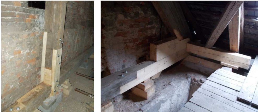
Příloha 13 Krov nad chrámovou lodí – oprava na štítové straně
