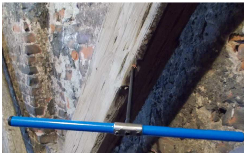
Obr. 18 Odběr vzorků pomocí Presslerova nebozezu
